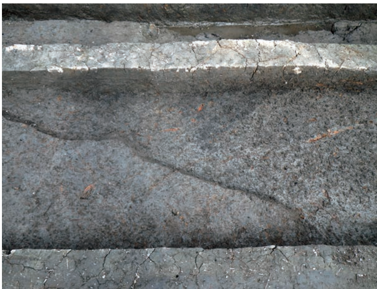
S K X 2161 盛土単位(西→) S X 2141 盛土整地地業の硬化面にも軟 質な部分がある。硬化部を取り巻く軟 質部がセットになって盛土 1 単位を形 成している。軟質部底面に植物遺体が 多く含まれていた。
