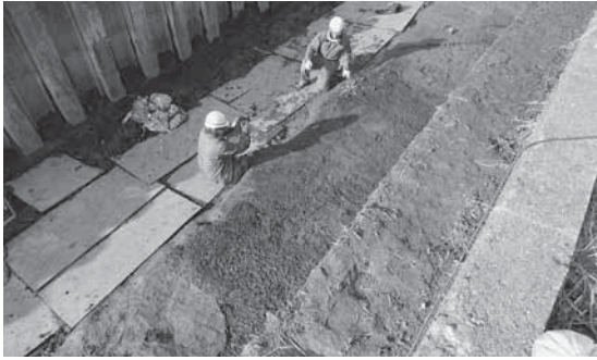
写真8 炭化物集中地点(南から)
