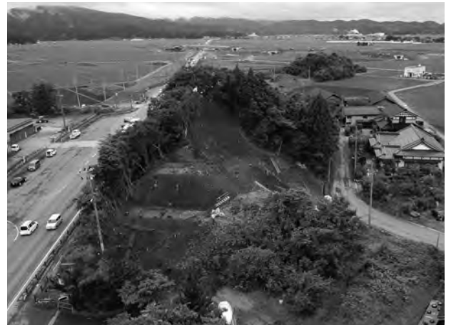
写真1 調査区全景 (東から)
