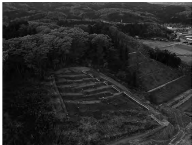
調査区全景（北から）
