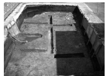
5区完掘状況（西から）
