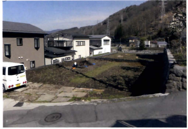
調査地全景（南から）
