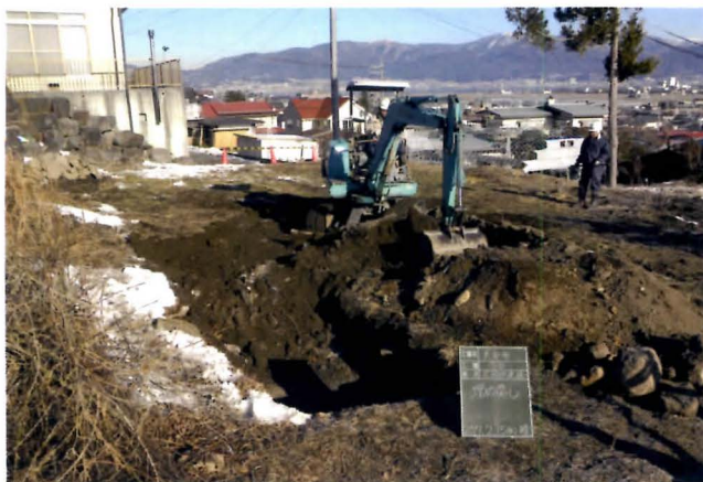
重機による埋め戻しの様子（南から）
