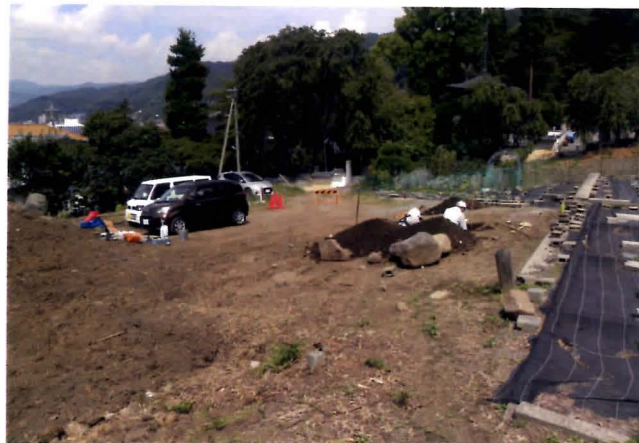
調査地全景（南から）
