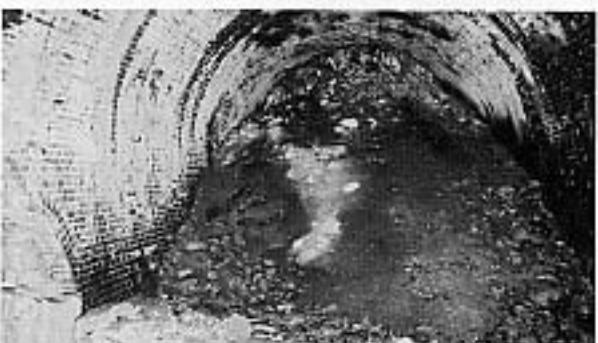
写真13 第七號隧道 内部の崩落 (02年12月)
