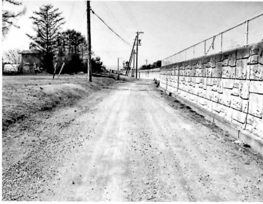
調査区全景（東側より）
