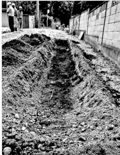
トレンチ2 (西側から)
