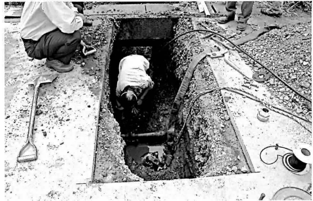
写真10 表町遺跡 (水道管敷設工事)
