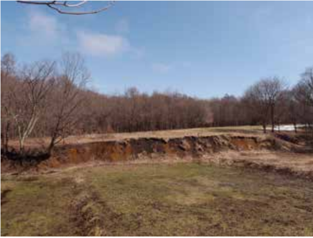
③ 与助尾根遺跡南斜面の崩落
