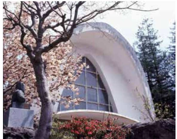
尖石考古館の建設（昭和 30 年）
