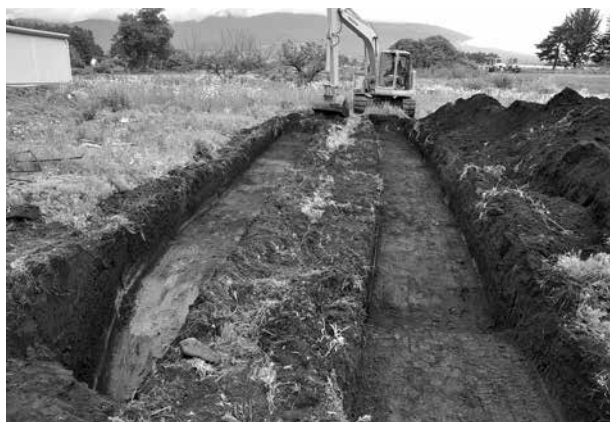
トレンチ掘削状況
