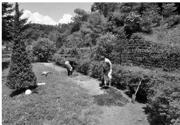
トレンチ掘削状況
