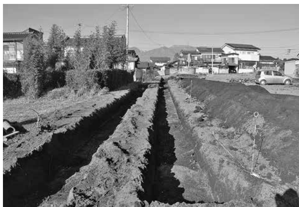
トレンチ掘削状況
