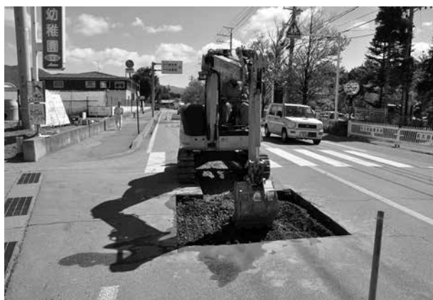
トレンチ掘削状況
