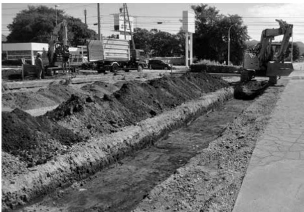
トレンチ掘削状況
