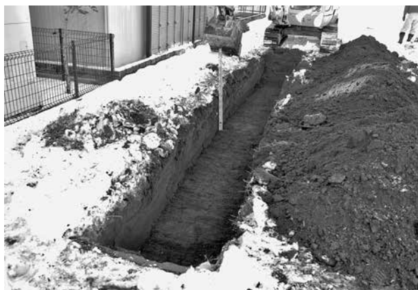
トレンチ掘削状況
