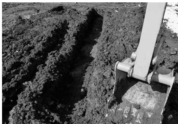
トレンチ掘削状況
