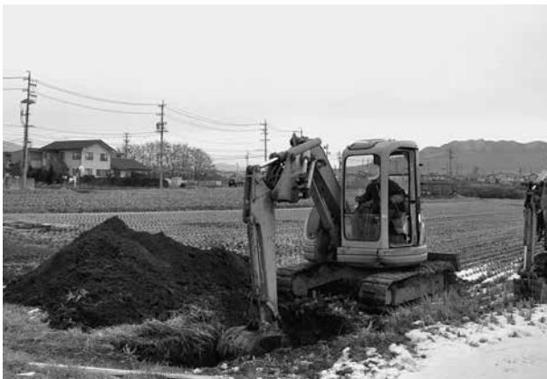
トレンチ掘削状況
