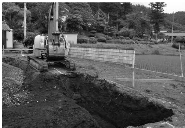
トレンチ掘削状況
