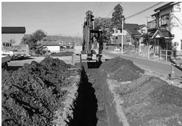
トレンチ掘削状況
