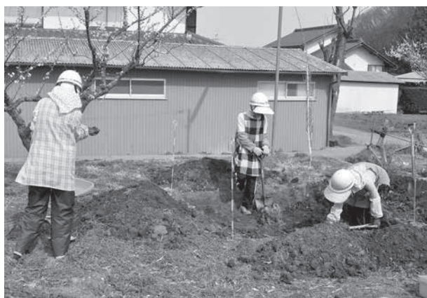
トレンチ掘削状況
