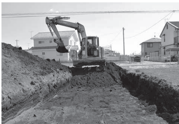
トレンチ掘削状況
