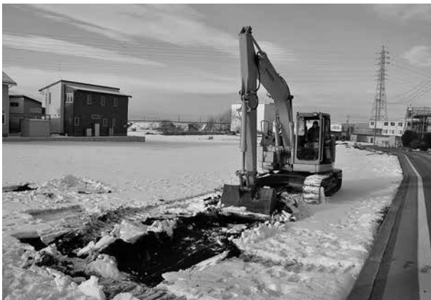
トレンチ掘削状況
