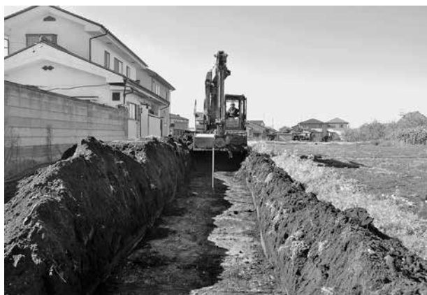
トレンチ掘削状況
