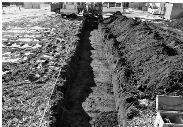
トレンチ掘削状況
