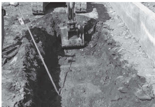
トレンチ掘削状況
