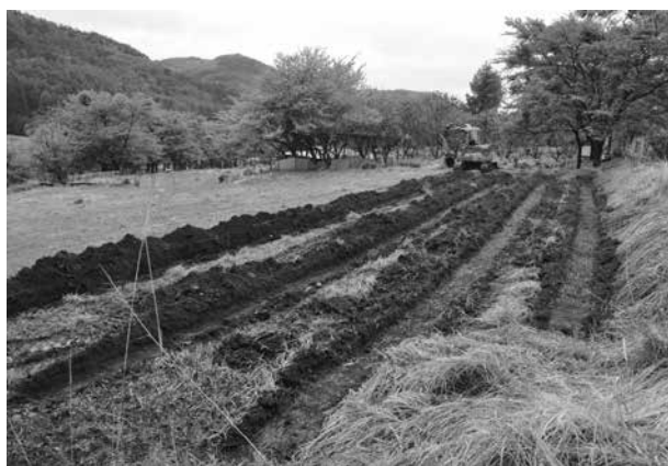
トレンチ掘削状況
