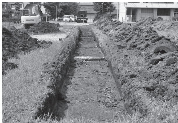
トレンチ掘削状況
