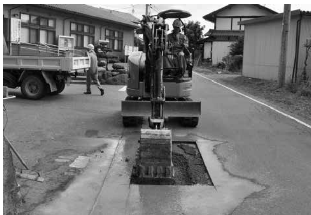
トレンチ掘削状況
