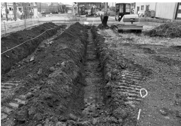
トレンチ掘削状況
