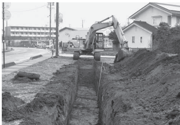
トレンチ掘削状況
