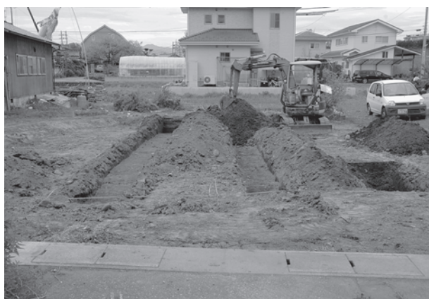
トレンチ掘削状況
