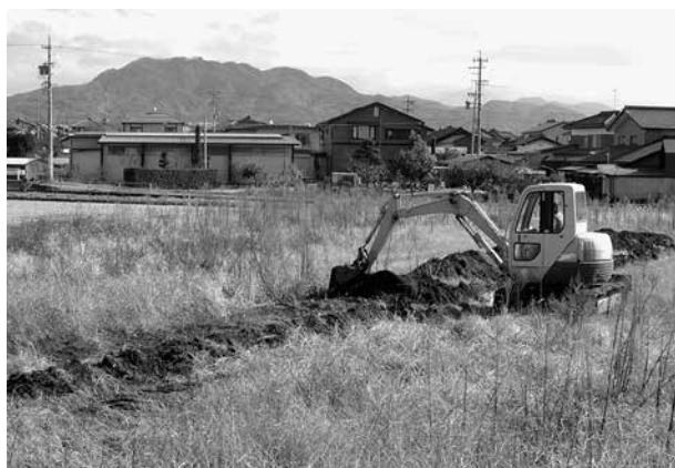
トレンチ掘削状況
