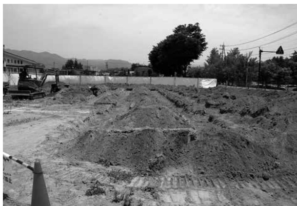
トレンチ掘削状況
