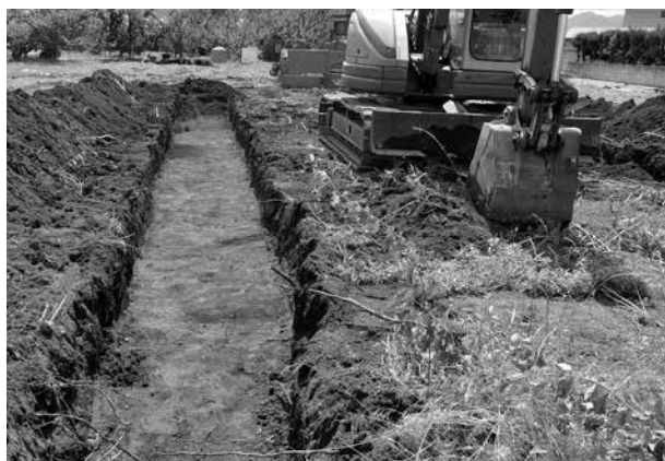
トレンチ掘削状況
