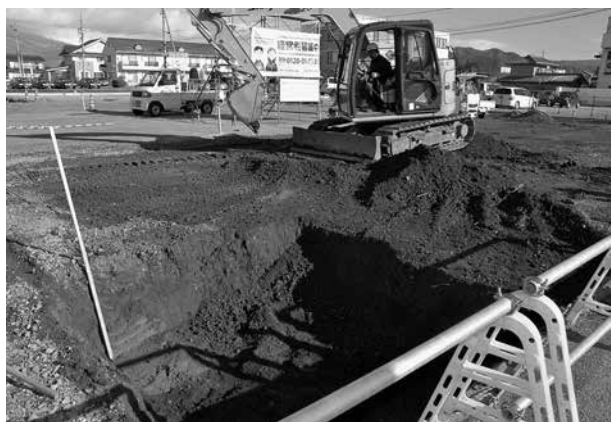
トレンチ掘削状況
