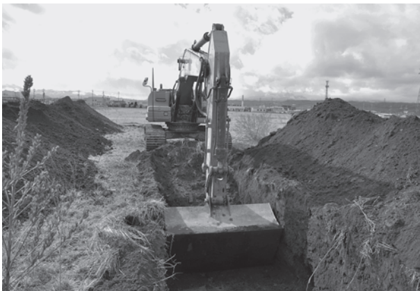
トレンチ掘削状況
