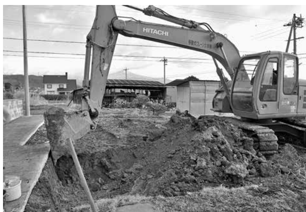
トレンチ掘削状況
