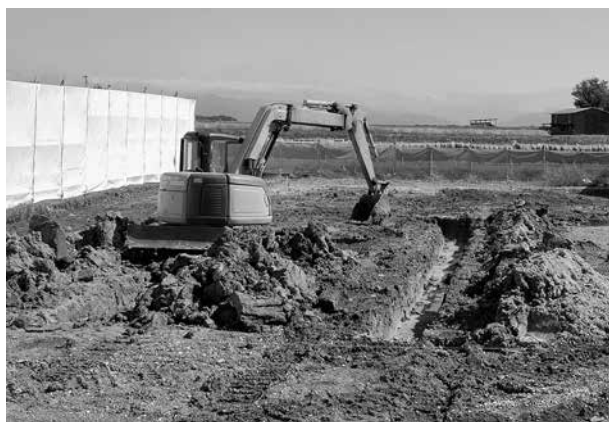
トレンチ掘削状況
