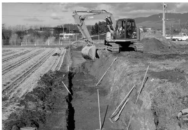
トレンチ掘削状況
