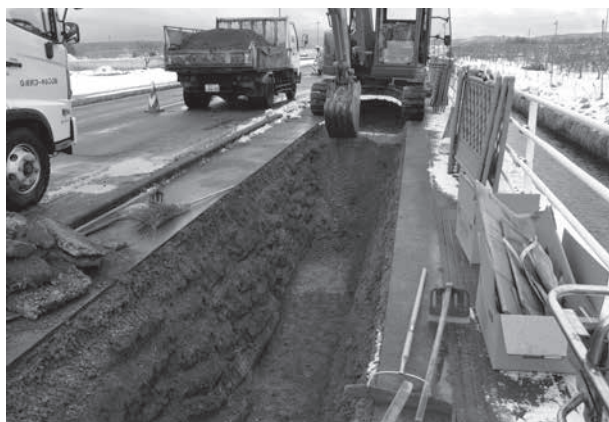
トレンチ掘削状況
