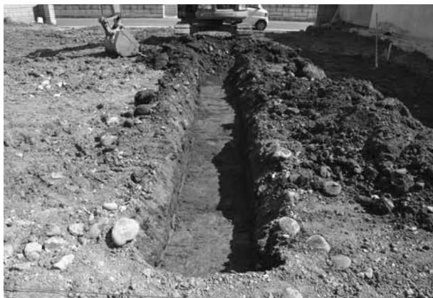
トレンチ掘削状況
