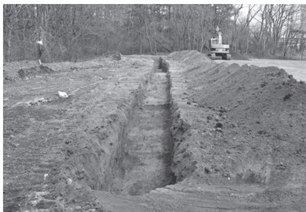
トレンチ掘削状況
