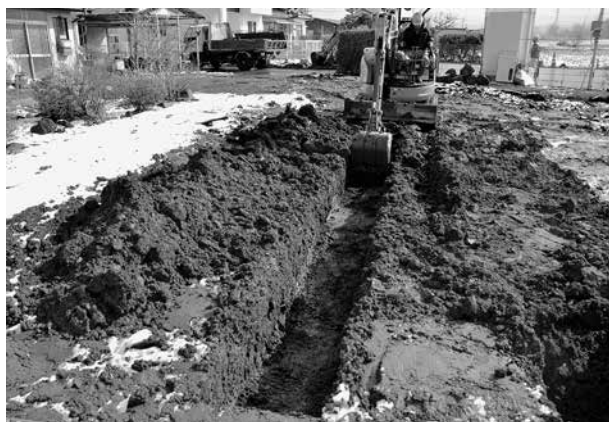
トレンチ掘削状況
