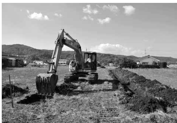
トレンチ掘削状況
