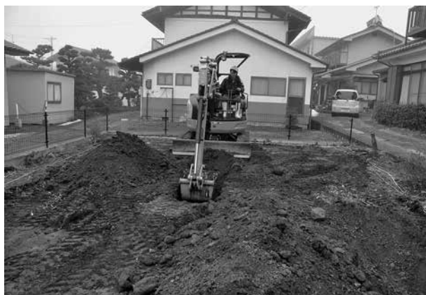
トレンチ掘削状況
