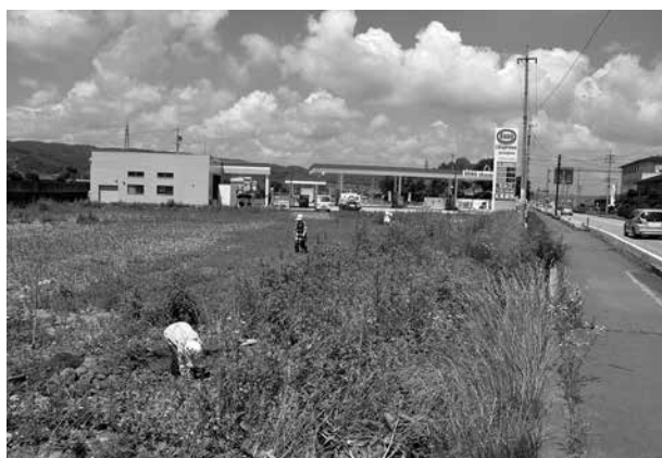
トレンチ掘削状況
