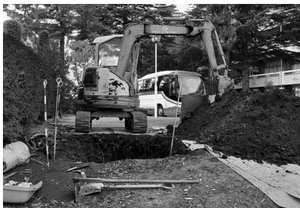
トレンチ掘削状況
