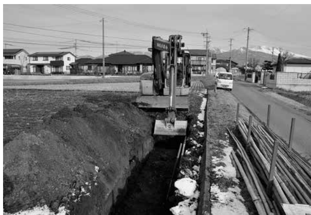
トレンチ掘削状況
