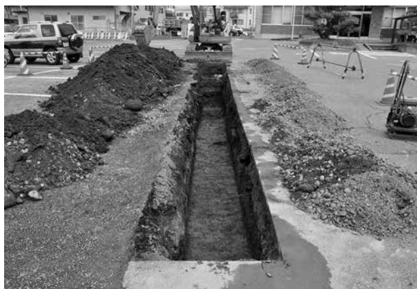
トレンチ掘削状況
