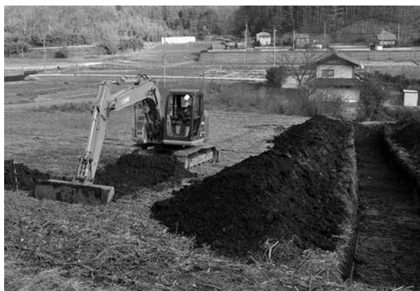
トレンチ掘削状況
