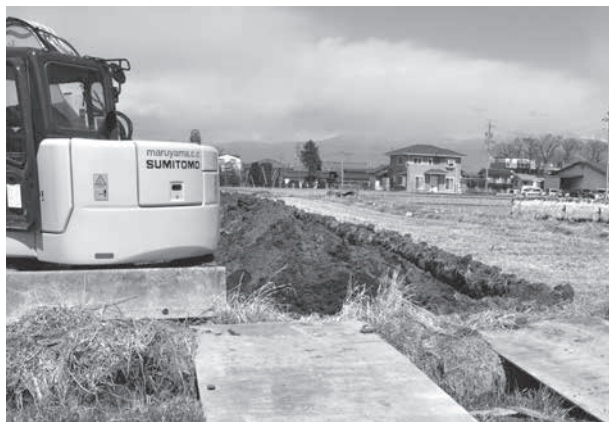
トレンチ掘削状況
