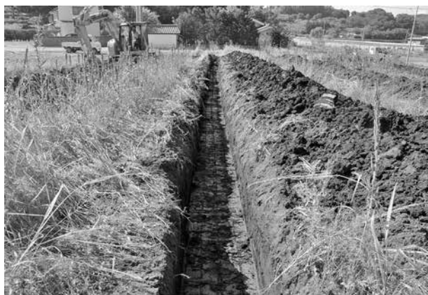
トレンチ掘削状況
