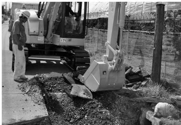
トレンチ掘削状況
