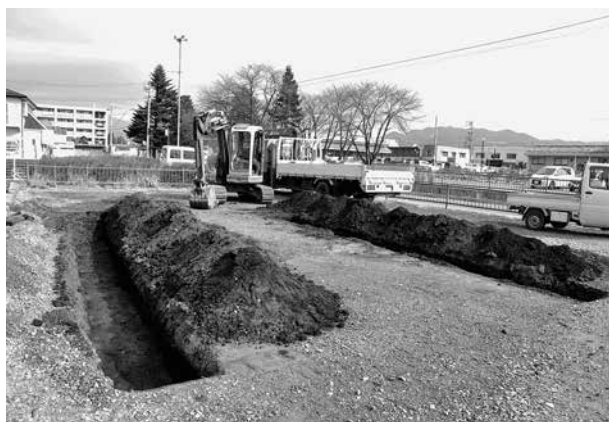
トレンチ掘削状況
