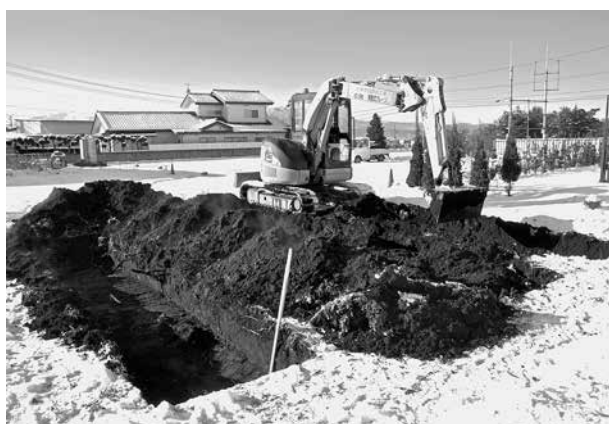
トレンチ掘削状況
