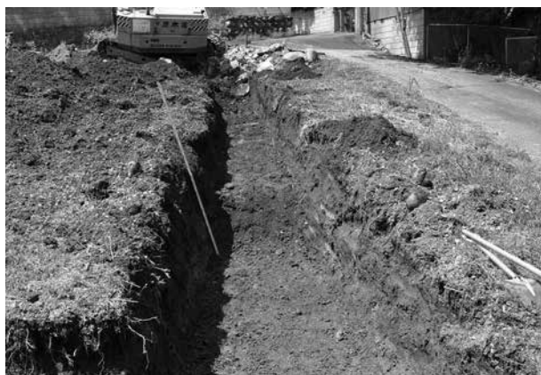
トレンチ掘削状況
