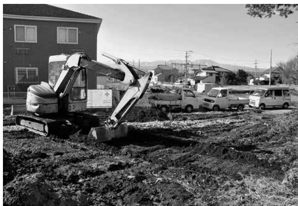
トレンチ掘削状況
