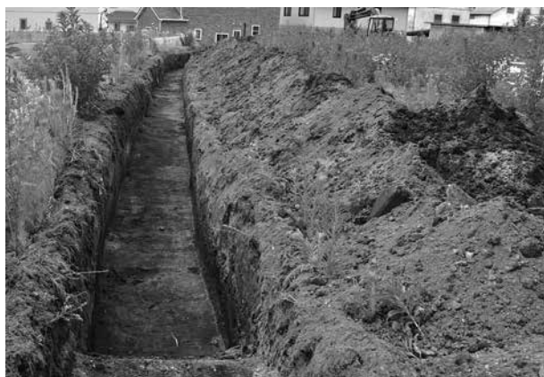
トレンチ掘削状況
