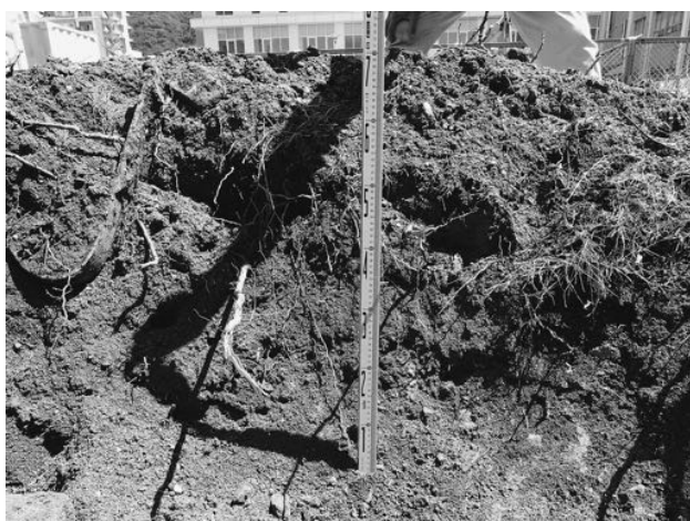
図4 (蔵本) 外来診療棟新営その他工事
