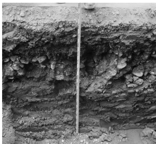
図6 (蔵本) 基幹・環境整備（排水設備等改修）工事
