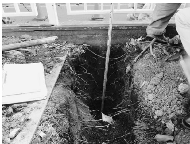
図 11 (新蔵) ガス管埋設工事
