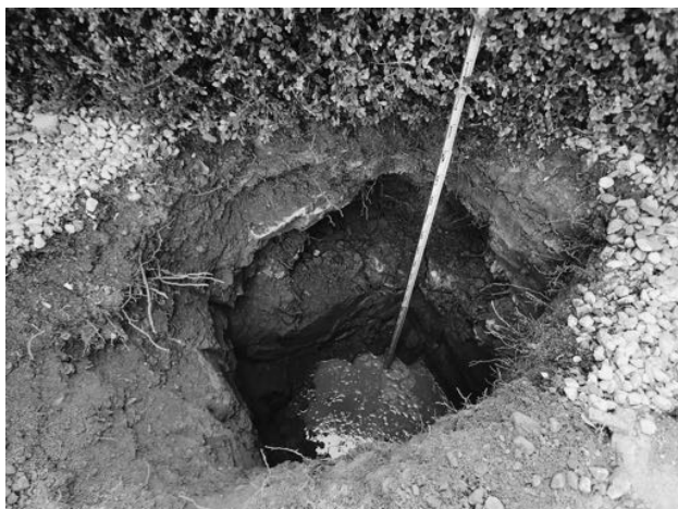
図 8 (南常三島) 外灯移設工事
