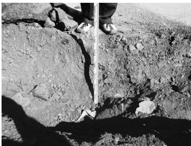
図 10 (南常三島) 囲障改修に伴う基礎取設
