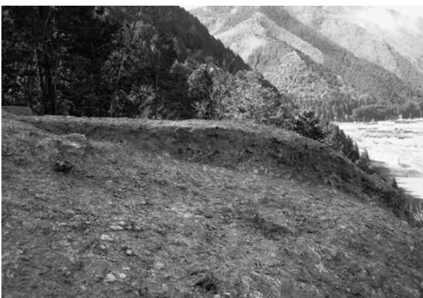
帯曲輪2盛土断面中央（東から）
