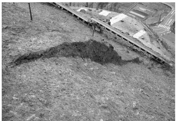
帯曲輪1東側盛土断面（南から）
