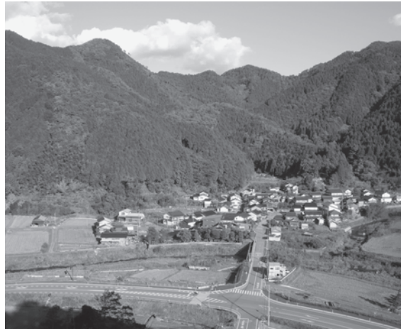
第36図 井垣城跡から見た稲津城と稲津里城跡（西から）
