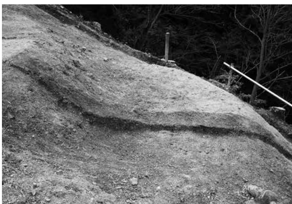
段状遺構断面 (東から)
