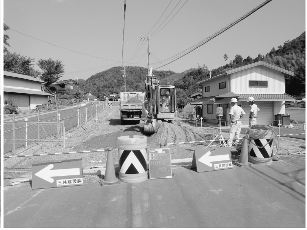
機械掘削状況（東から）
