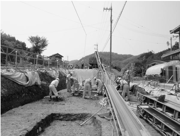
作業状況①
