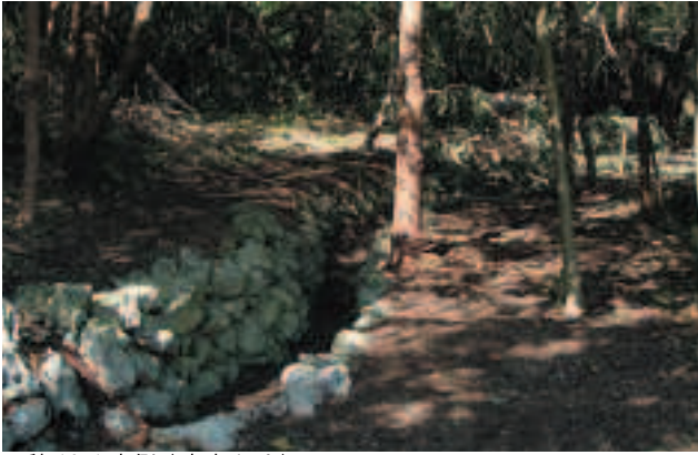
石積 16-1 南側（南東より）
