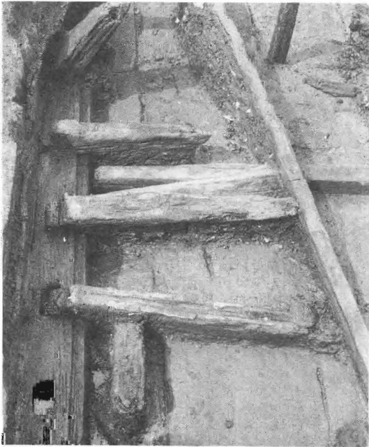
▲ 倒覆した南壁の間柱と胴縁
