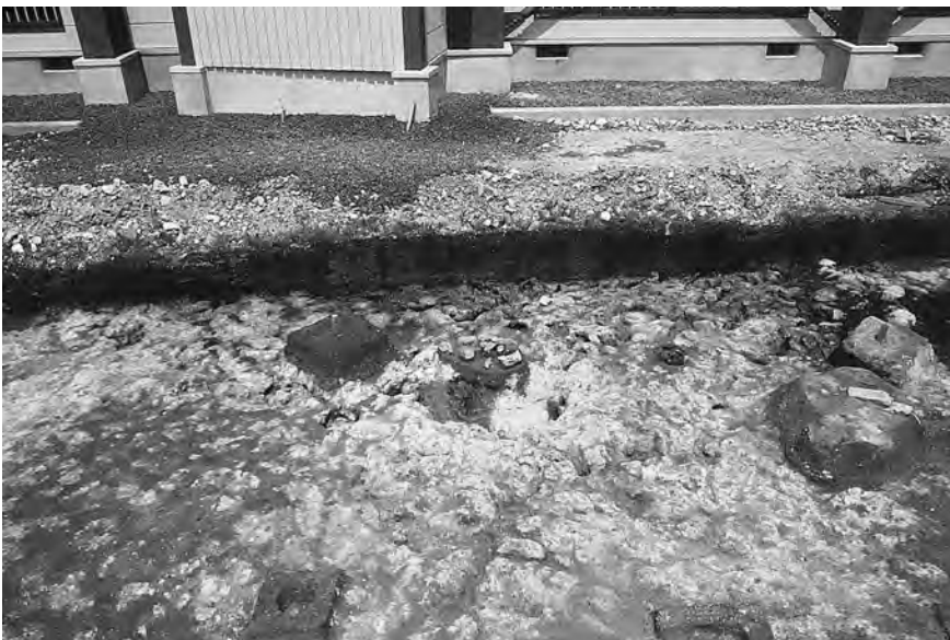
S K 8 北西より
