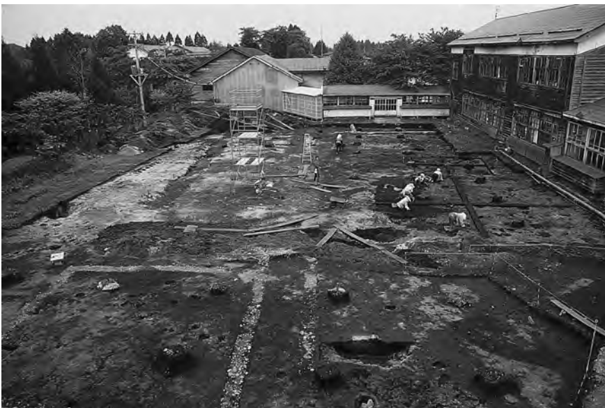
Ⅲ区西部 北東より
