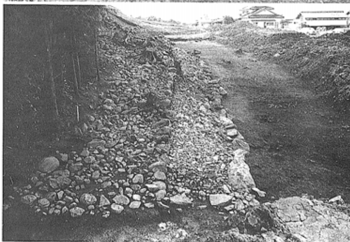
石垣全景（東より）
