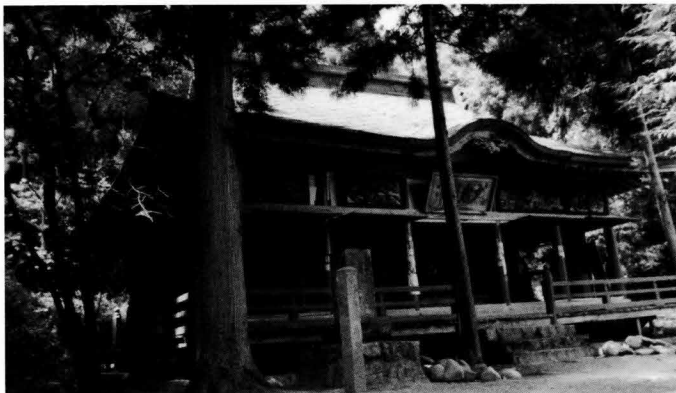
盛泉寺に移された若澤寺中堂救世殿
