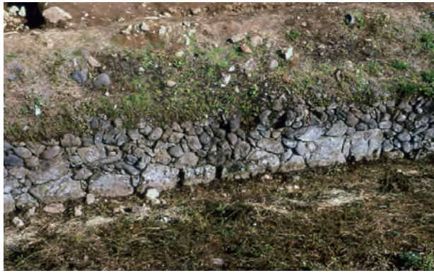
A区西面を区画する石垣(西側から撮影す) 下段の石の積み方が上段とは異なっている
