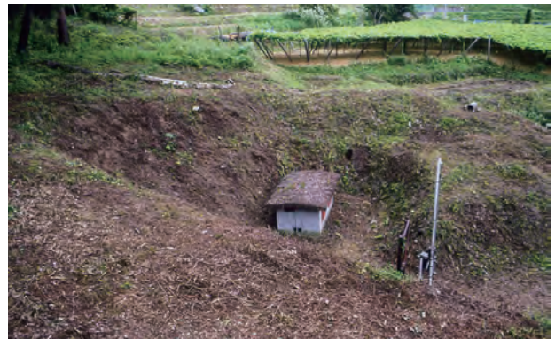
10工 現況(樹木等清掃後)
