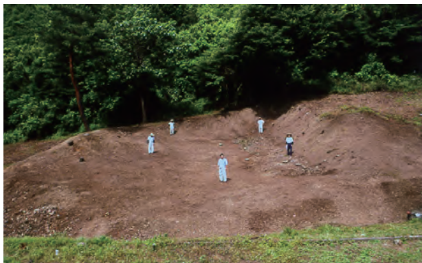
9工 現況(樹木等清掃後)
