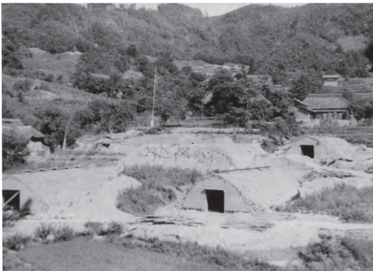
写真1 林地区の半地下工場
