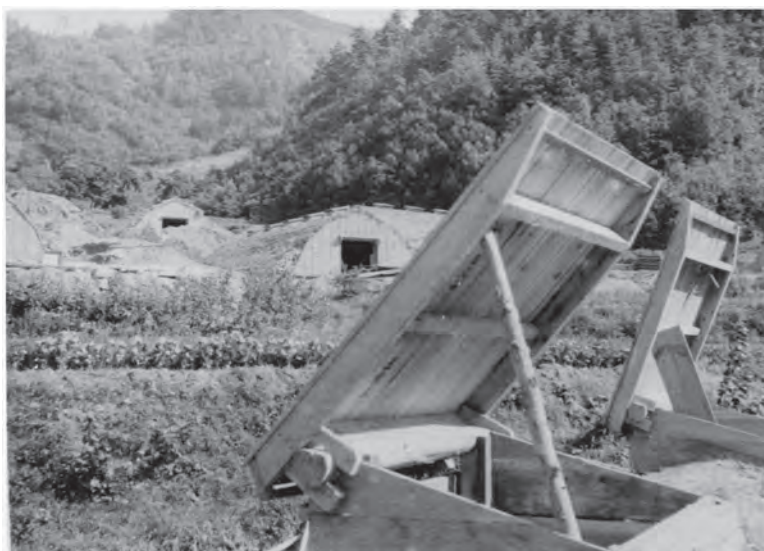
写真2 半地下工場の窓
