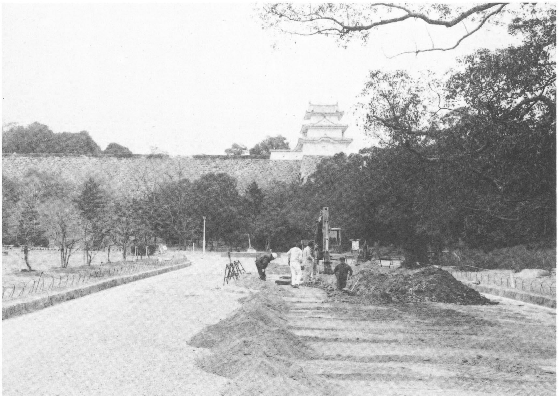
調査地全景（南から）
