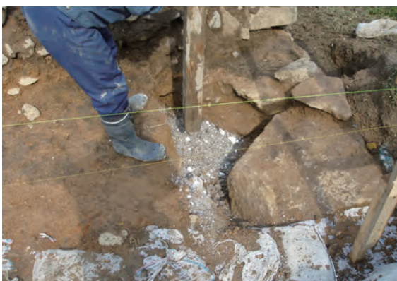
裏込補強作業
