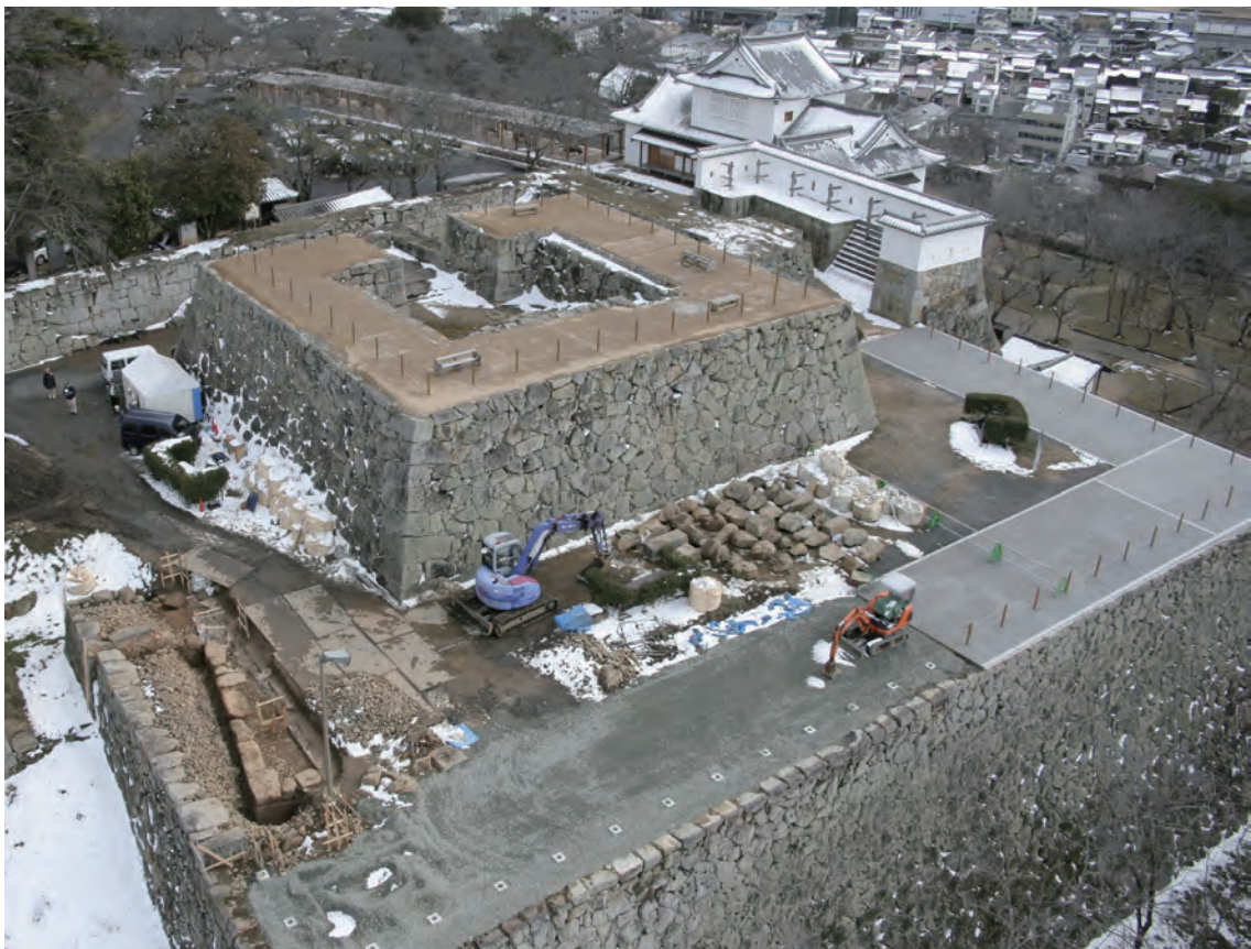
埋没石垣発見時航空写真（写真左が埋没石垣）
