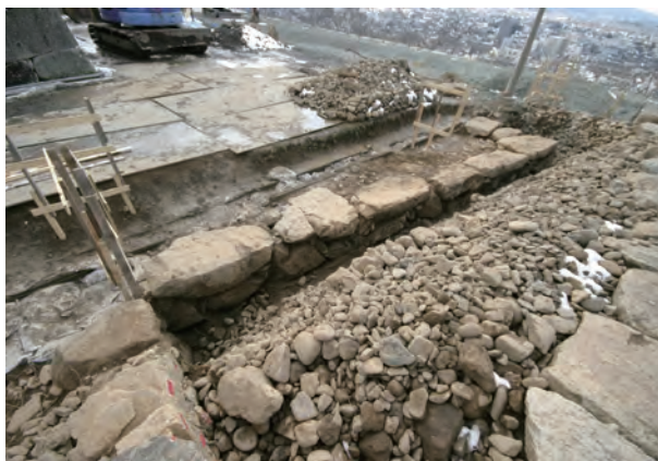
写真7 埋没石垣（北東から）
