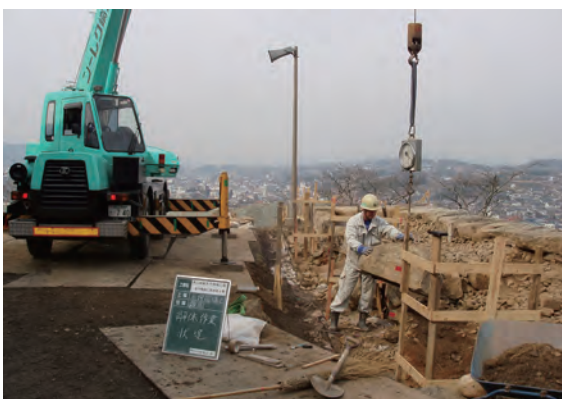
石垣解体作業
