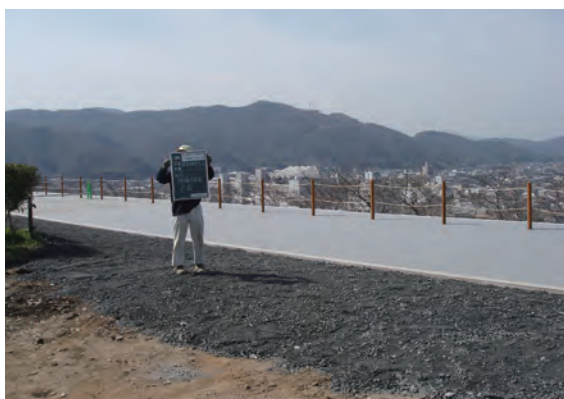
自然石樹脂舗装完了
