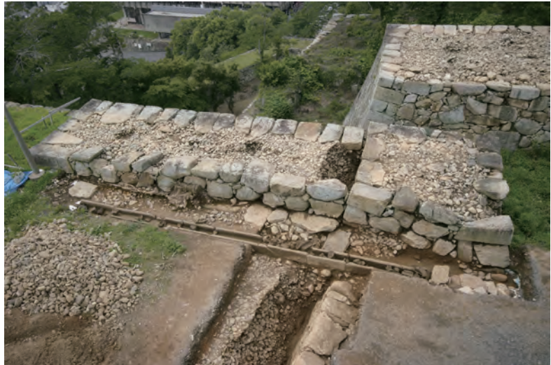
写真1 調査区2 七番門南石垣及び多門櫓腰石垣調査区（南から）
