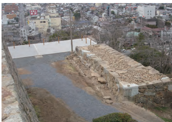
整備工事完了 (東から)
