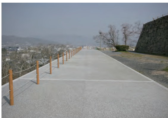
整備工事完了 (南から)
