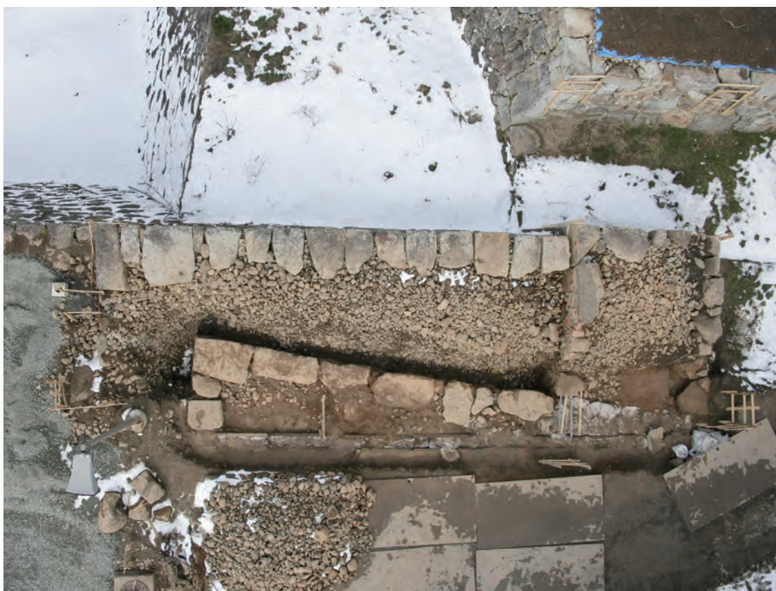
埋没石垣全景（上が北）
