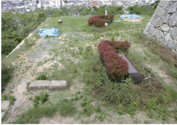
工事着手前（南から）
