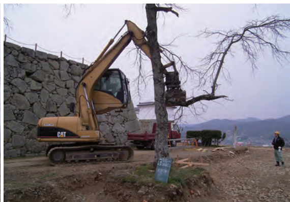
樹木伐採作業
