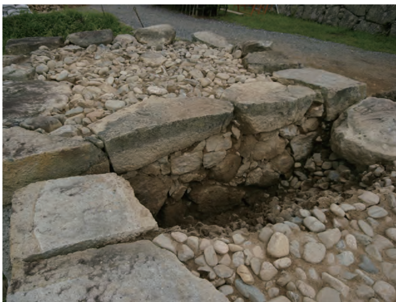
3. 調査区2七番門南石垣西面 検出状況（北西から）
