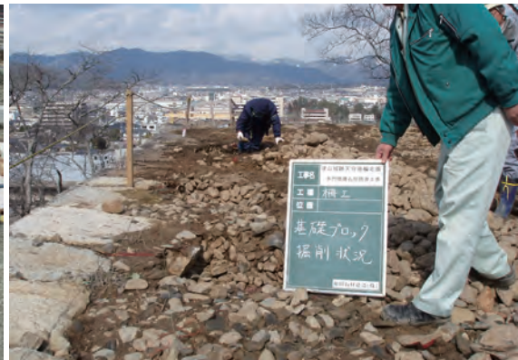
転落防止柵基礎ブロック掘削
