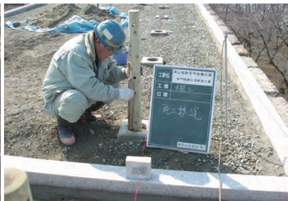
転落防止柵据え付け
