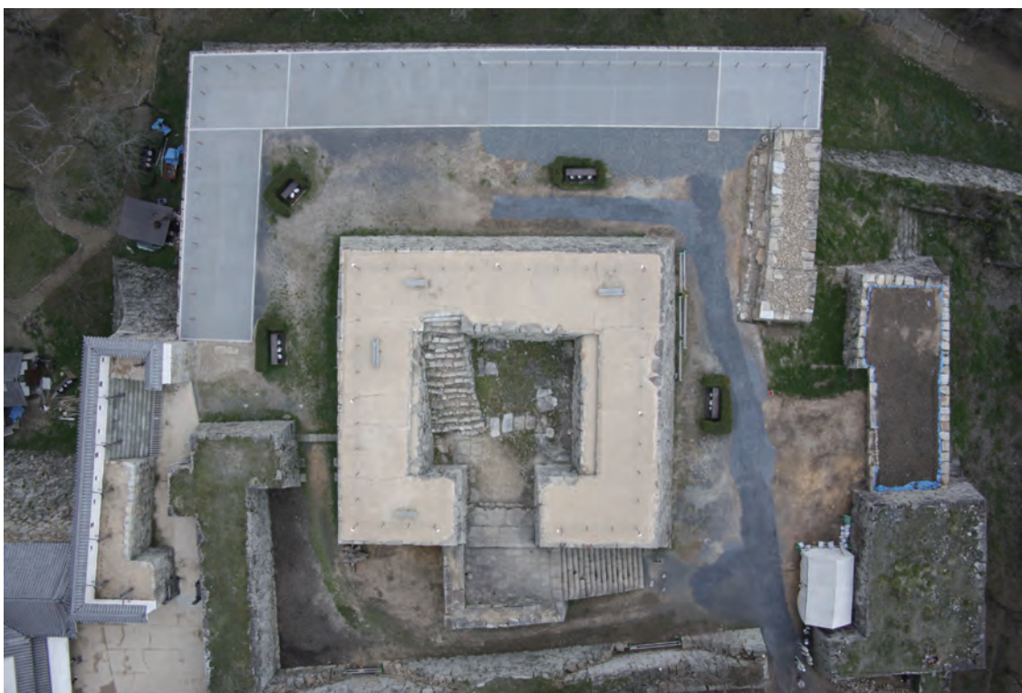
平成 19 年度整備工事終了後航空写真 2
