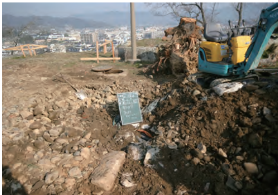
ハンドホール移設作業
