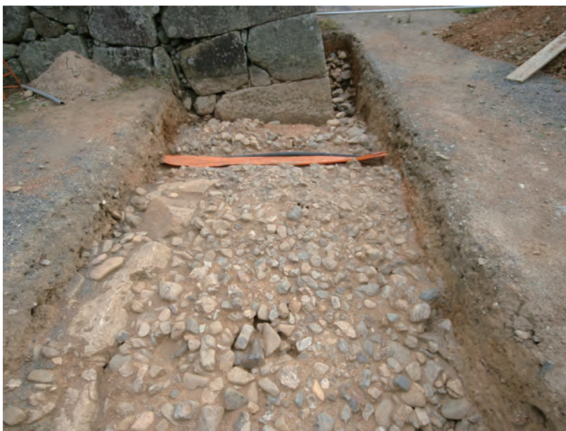
2. 調査区 3 天守曲輪通路部分 埋没石垣検出状況 (北から)
