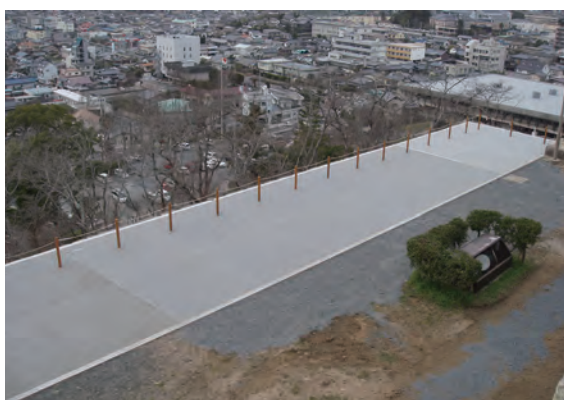
整備工事完了 (南東から)
