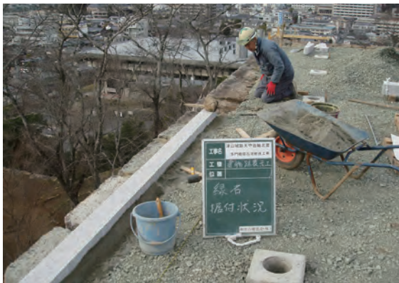
縁石据え付け
