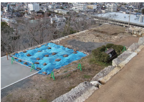
整備工事着手前（南東から）
