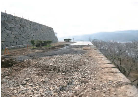
舗装後（北から）
