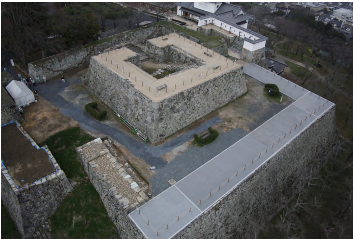
平成 19 年度整備工事終了後航空写真 1
