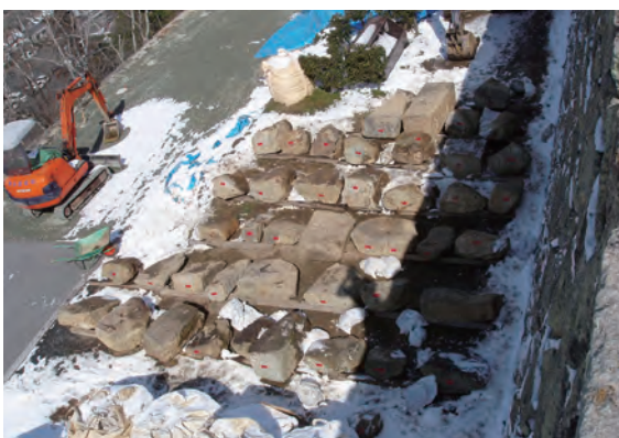
解体した石の仮置き
