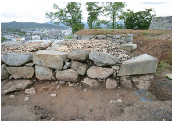
七番門南石垣南面修理前（南から）
