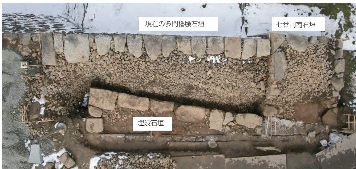
写真6 多門櫓腰石垣から検出された埋没石垣（上が北）
