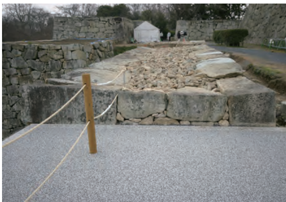
石垣解体修理完了（多門櫓腰石垣西面）
