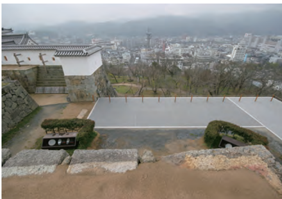
舗装後（北から）
