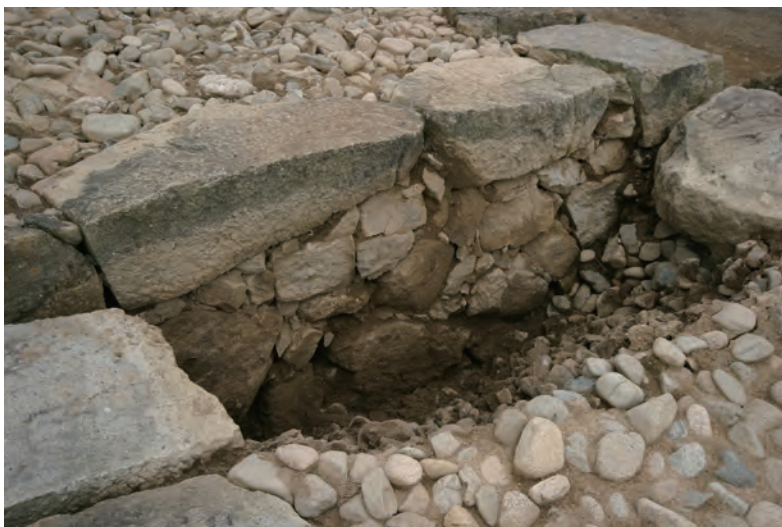
写真2 調査区2 七番門南石垣西面（東から）
