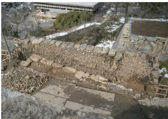
解体中に発見された埋没石垣
