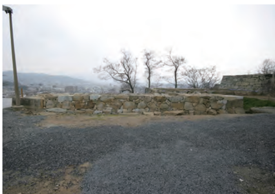
石垣解体修理完了 (全体)
