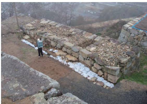
整備工事着手前（南東から）
