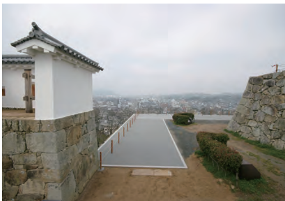
舗装後（東から）
