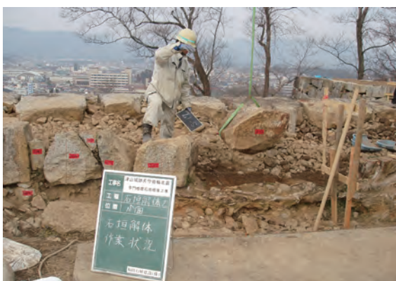
石垣解体作業
