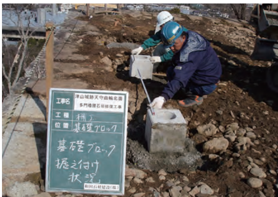
転落防止柵基礎ブロック据え付け
