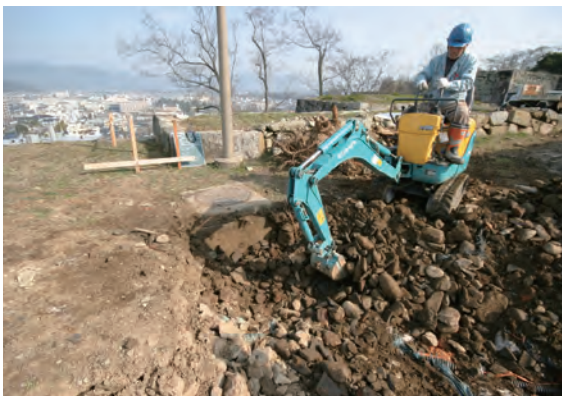
ハンドホール移設作業
