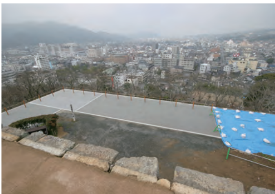
舗装後（北東から）
