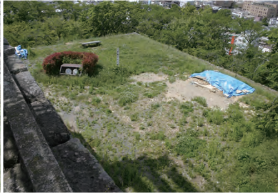
工事着手前（東から）
