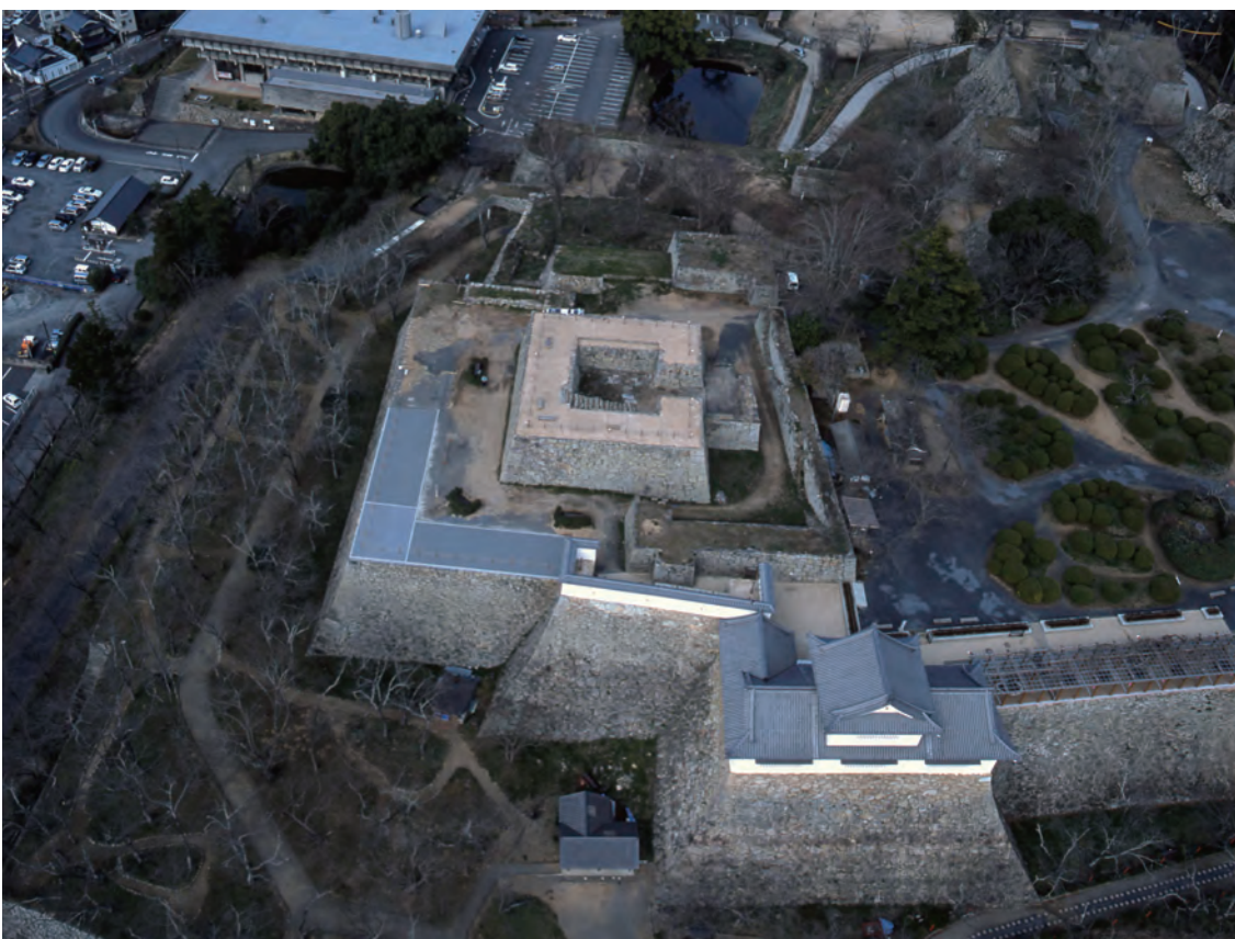
平成 18 年度整備工事終了後航空写真
