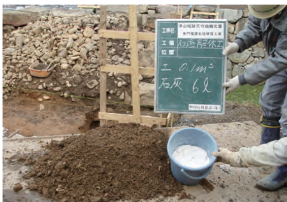
裏込補強状況
