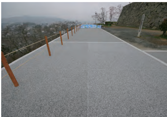
舗装後（南から）
