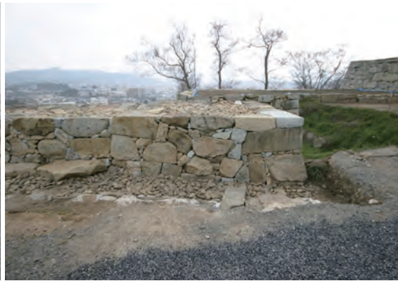
石垣解体修理完了（七番門南石垣南面）
