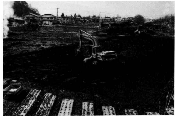
写真2 重機による表土剥ぎ作業
