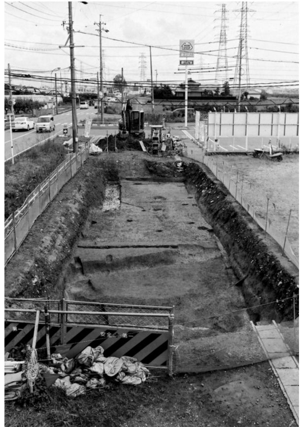
B地点 (AG1 ~ AG5 グリッド) 近景 (西から)
