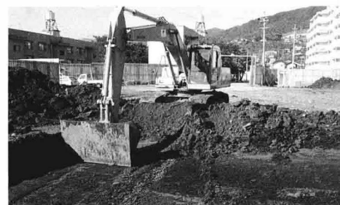
重機による表土剥ぎ
