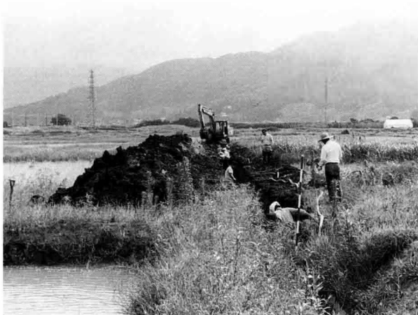
試掘坑掘削状況
