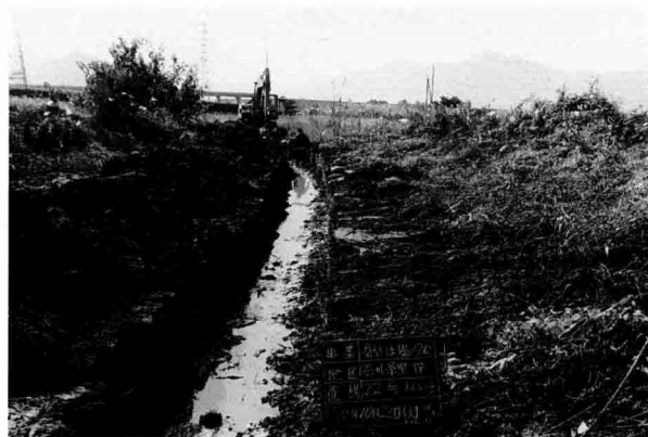
22号トレンチ掘削状況
