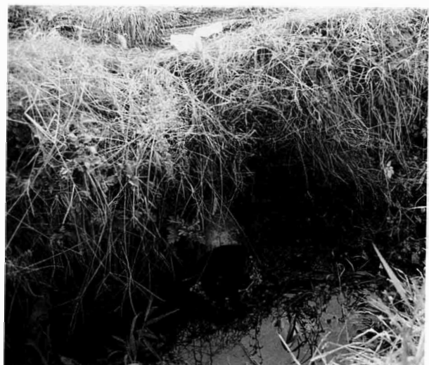
水路への暗渠の落し口
