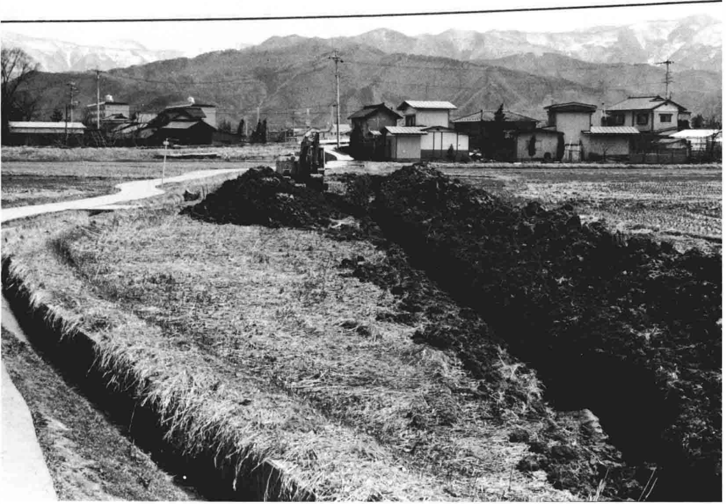
第 8 号トレンチ
