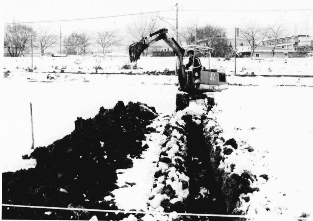
試掘坑(No. 5)掘削状況
