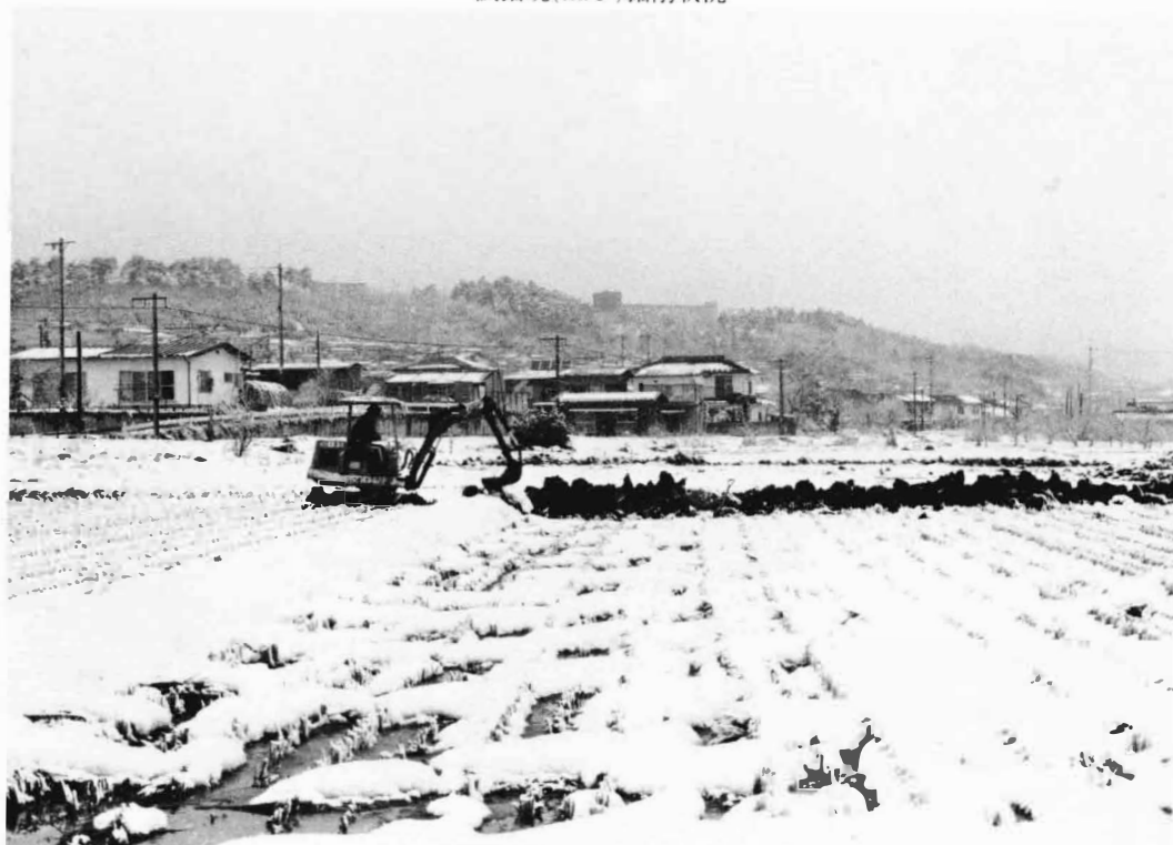
試掘坑(No. 4)掘削状況
