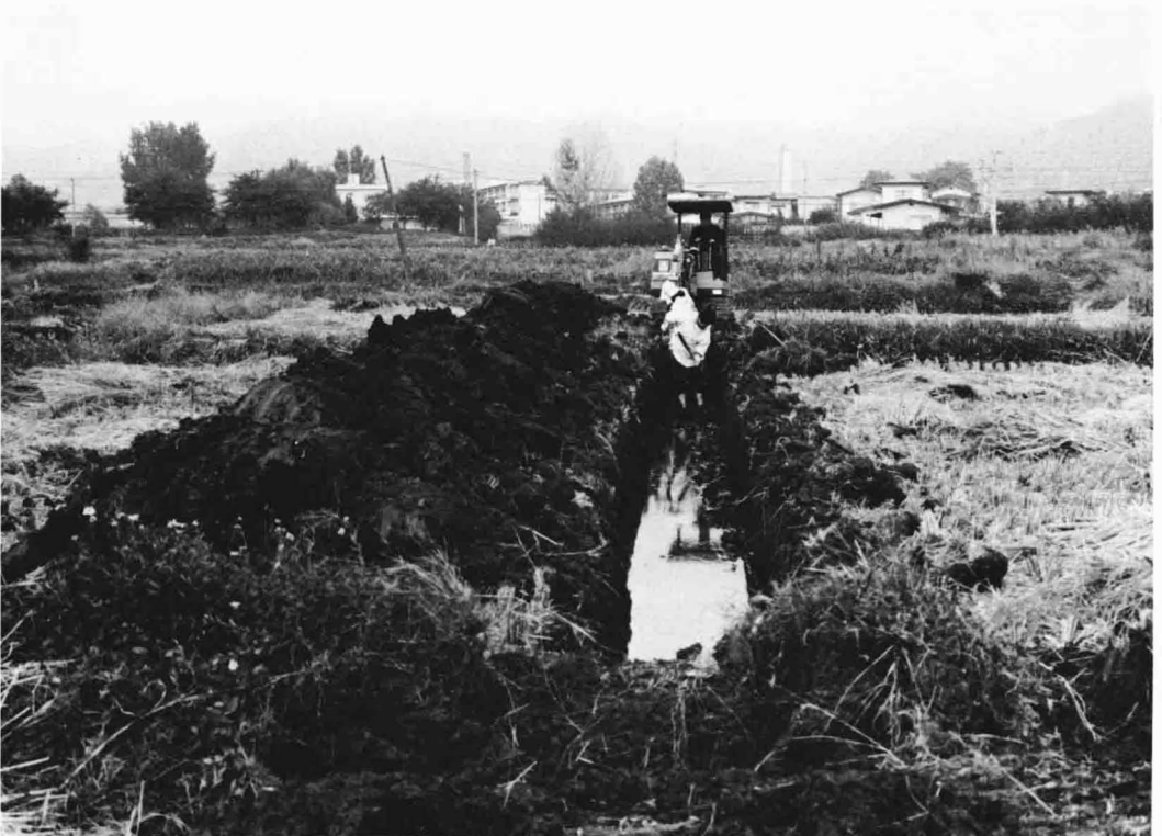
試掘坑(No. 2)掘削状況
