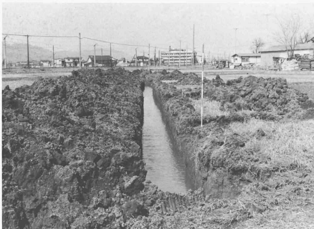
第9号トレンチ
