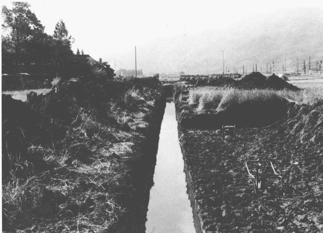
第10号トレンチ
