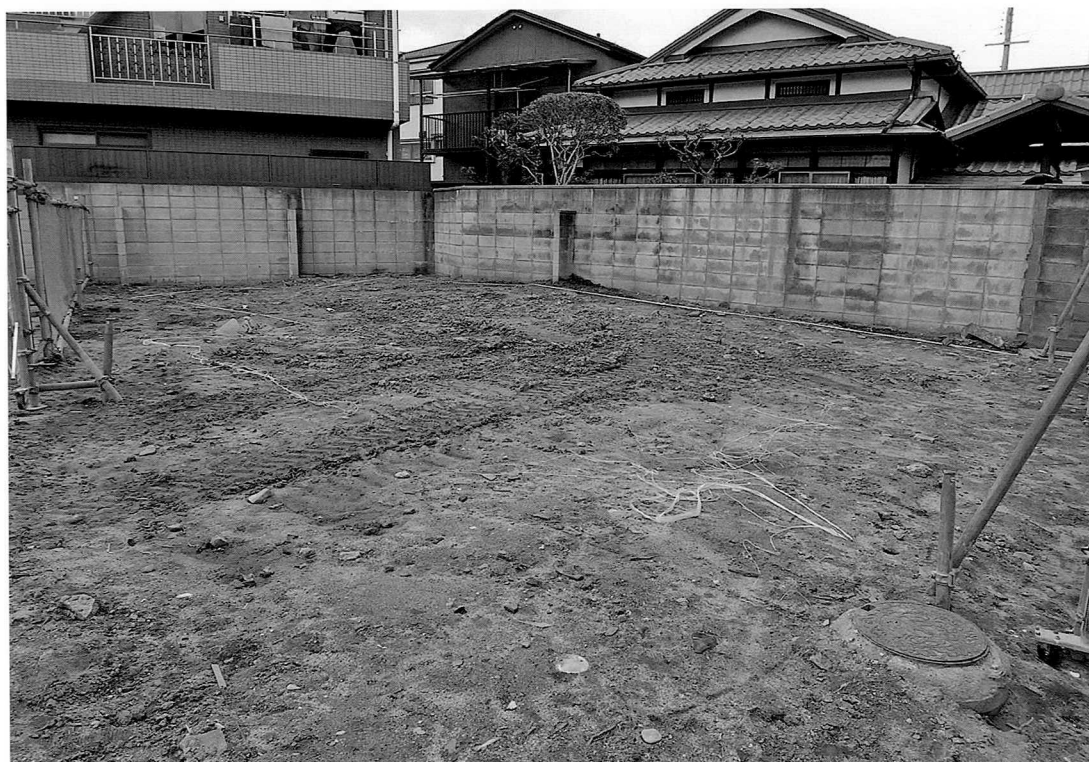
調査地近景（南東から）
