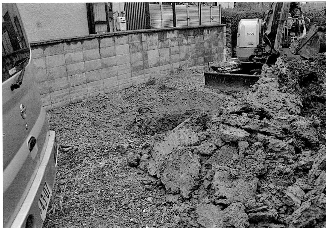
調査区近景（北から）
