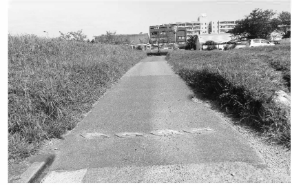
着手前状況（南から）
