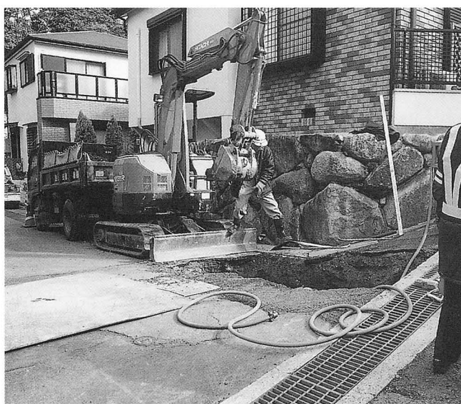
B 地区調査状況
