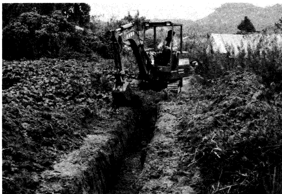
調査風景 機械(バックホー)によるトレンチの掘削
