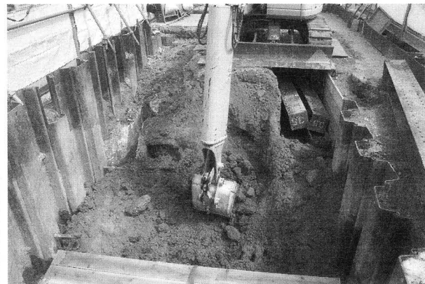
府道部掘削立会(南から)
