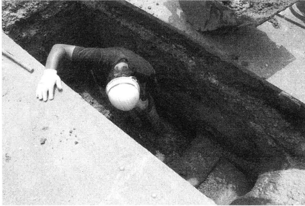
試掘 8 掘削状況(北東から)
