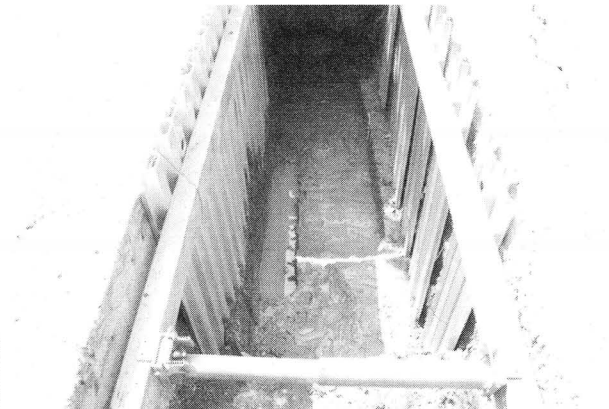
4区西半(東から)
