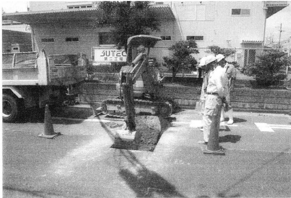
試掘15機械掘削(南から)
