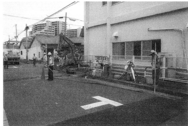
試掘21調査状況(北西から)
