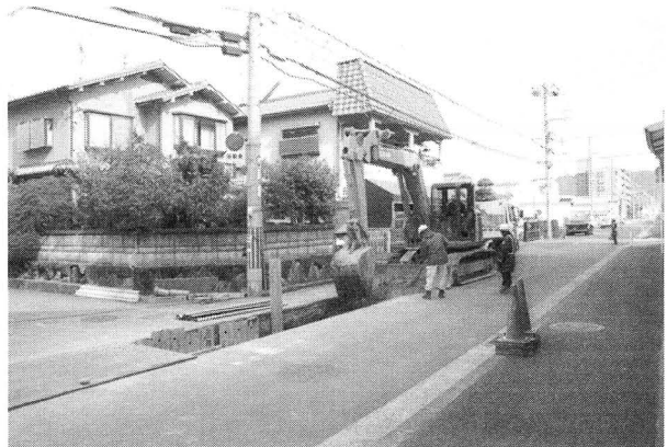
立会12(南西から)
