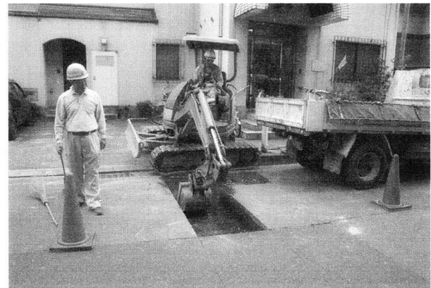
試掘16機械掘削(北から)
