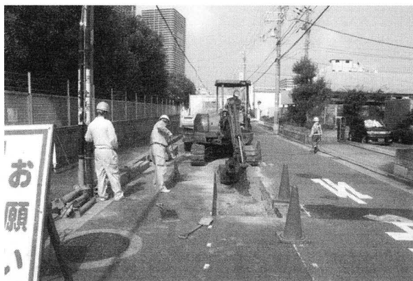
6区機械掘削(東から)
