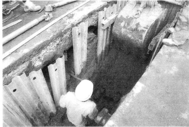
立会15(南西から)
