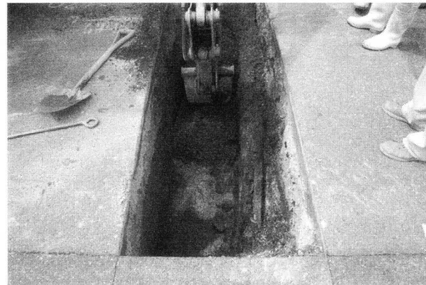
試掘10機械掘削(北から)
