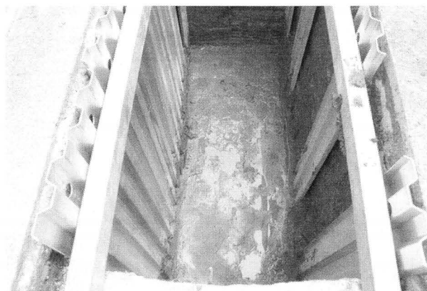
4区東半(西から)
