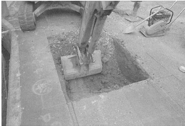
9区機械掘削(南から)
