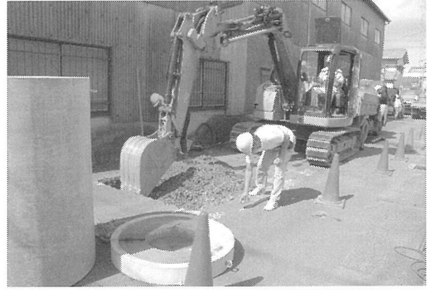
3区機械掘削(北東から)
