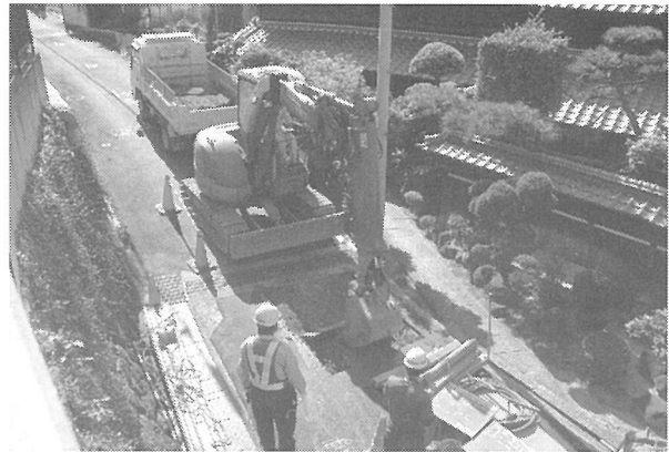
1区機械掘削(北西から)
