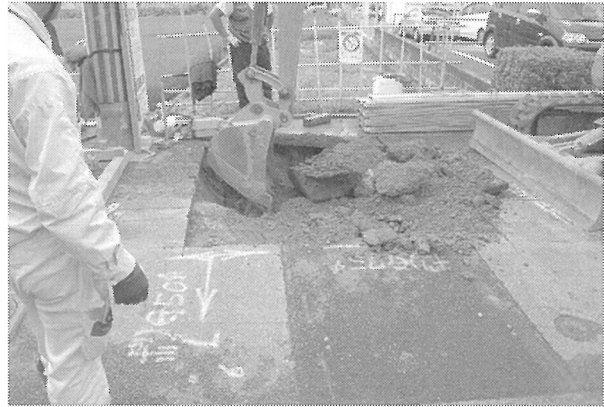
1区機械掘削(北から)
