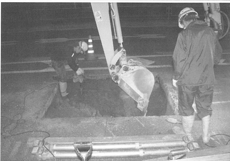
掘削状況(東から)
