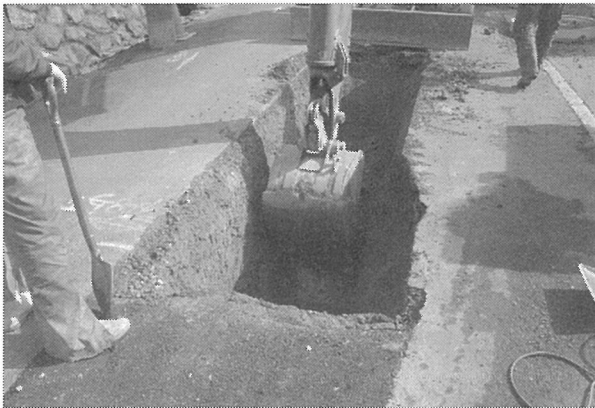
4区機械掘削(西から)
