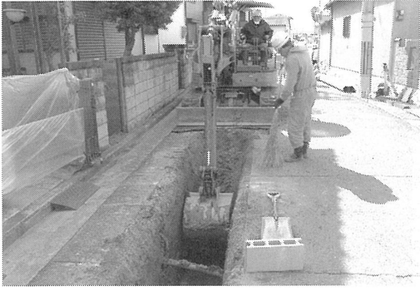
1区機械掘削(北西から)
