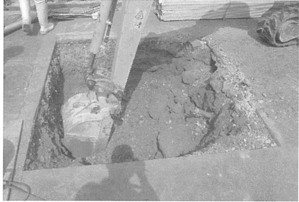
1区機械掘削(東から)
