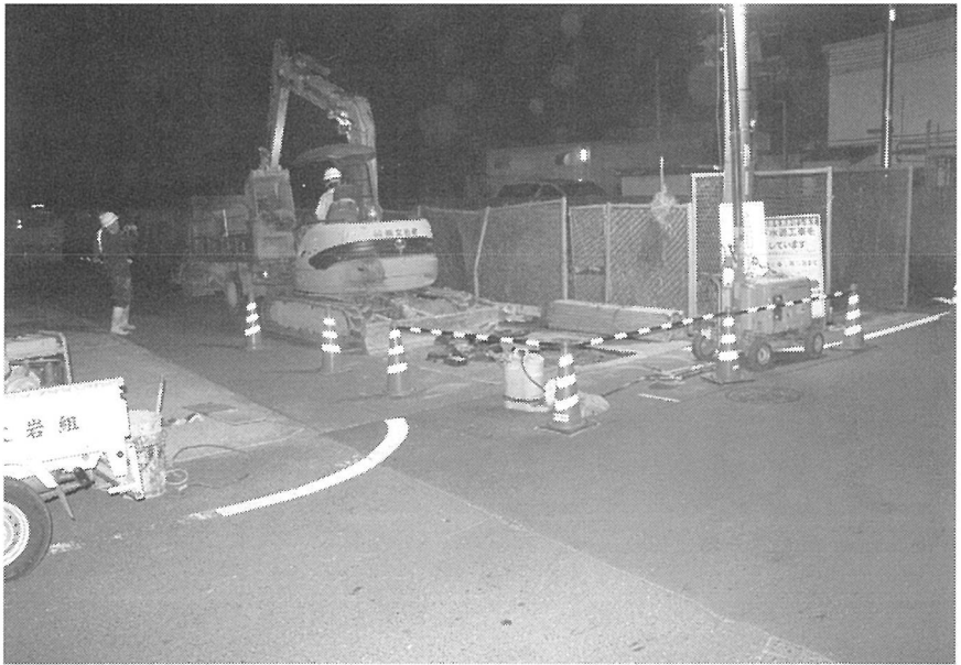
掘削状況(北東から)
