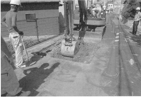
1区機械掘削(東から)
