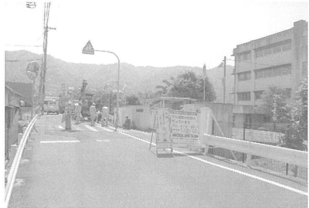
3区調査地(西から)
