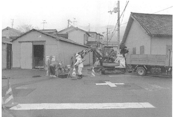
5区機械掘削(西から)
