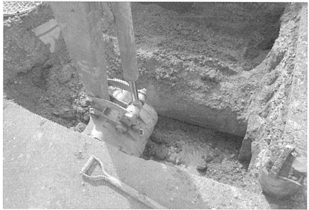
機械掘削(北西から)
