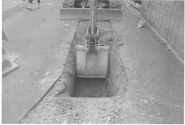
1区機械掘削(西から)
