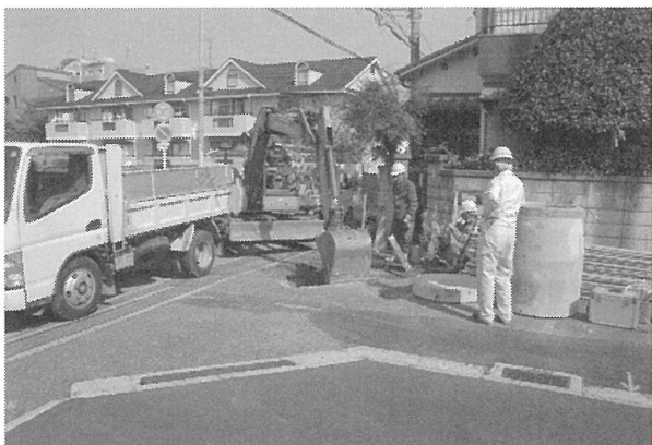
3区機械掘削(南西から)
