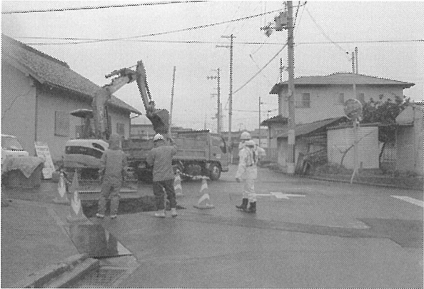
5区周辺(北から)
