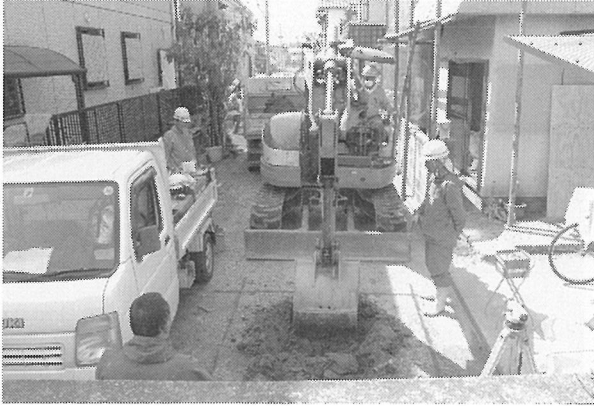
4区機械掘削(東から)
