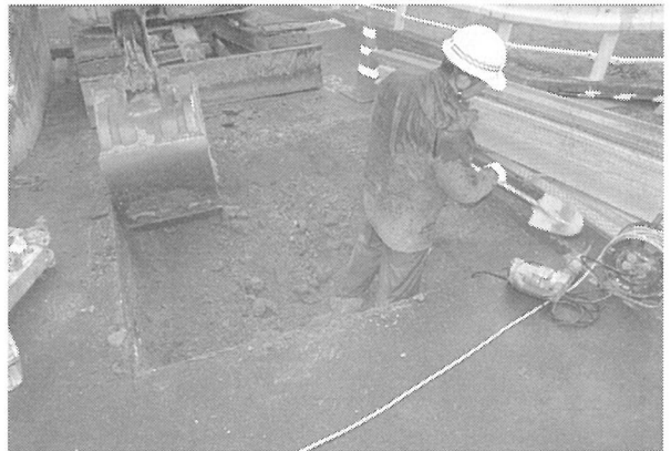
5区機械掘削(東から)
