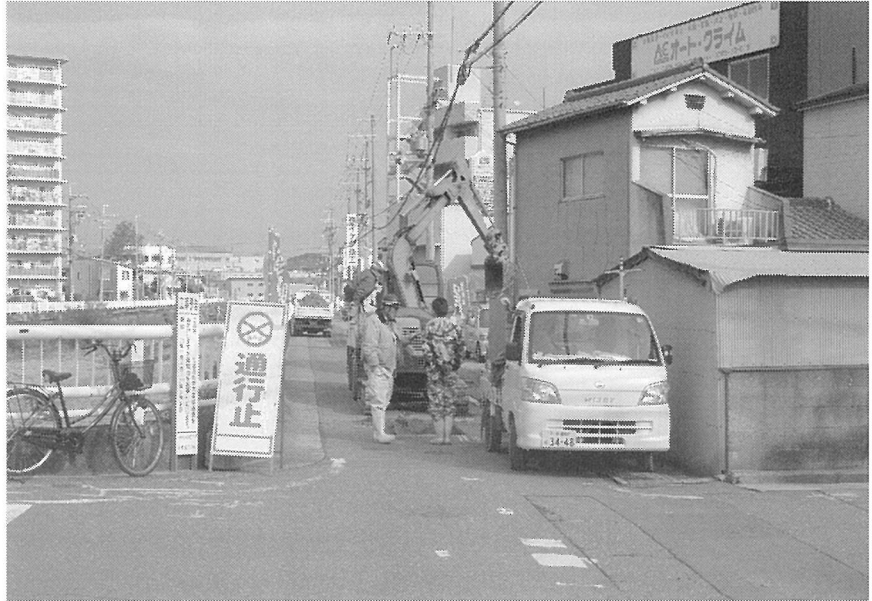
2区調査地周辺状況(南から)
