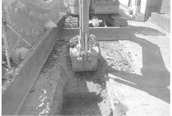
1区機械掘削(北から)
