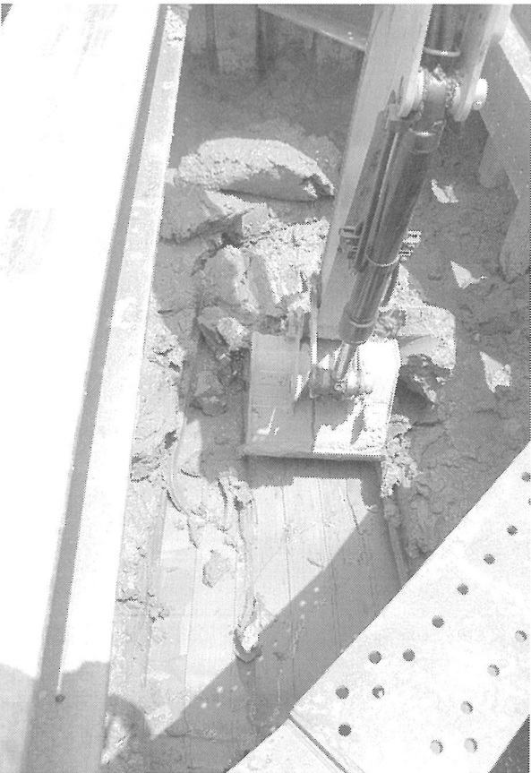
1区下層機械掘削(西から)
