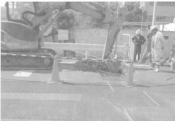
3区機械掘削(北から)
