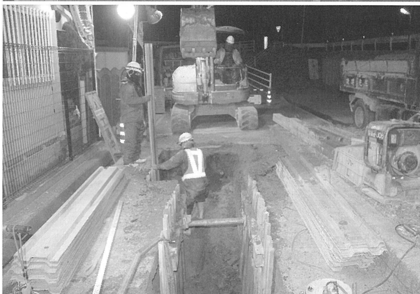
調査区掘削状況(北から)
