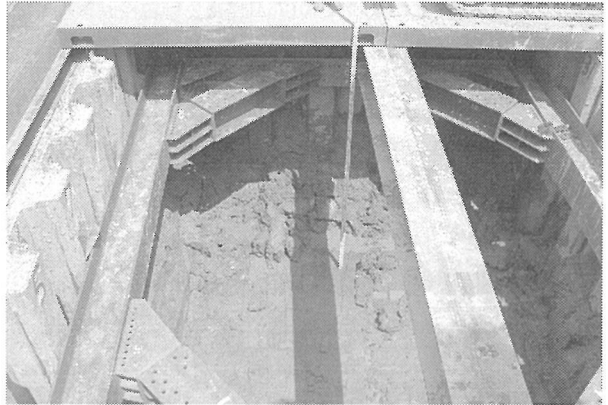
1区7層上面(西から)
