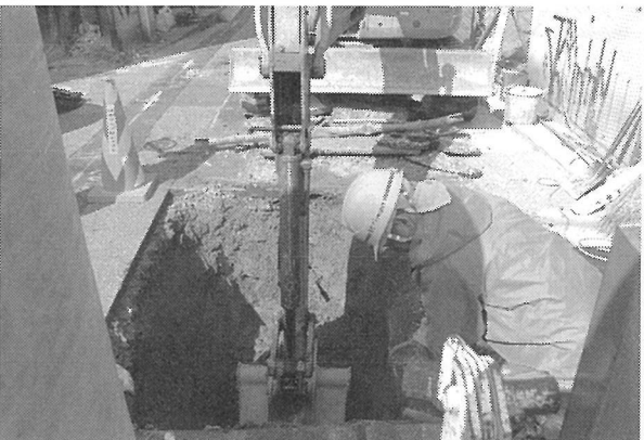
6区機械掘削(東から)
