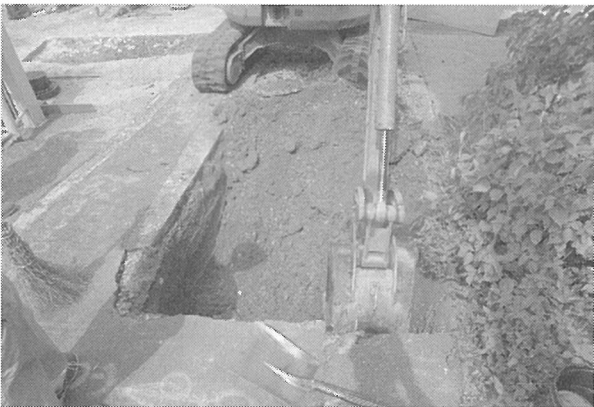
2区機械掘削(東から)
