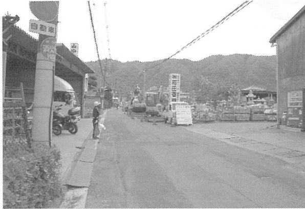
1区調査地(西から)
