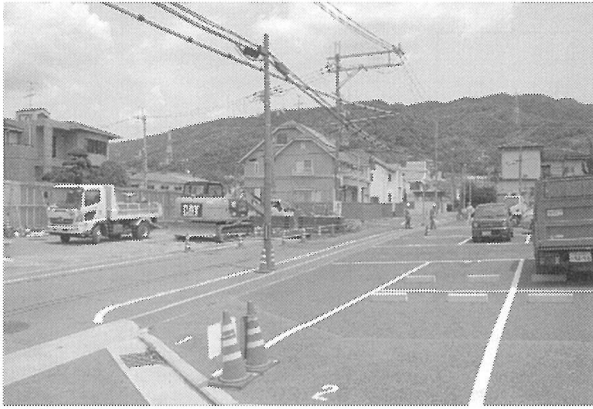
調査地(南西から)
