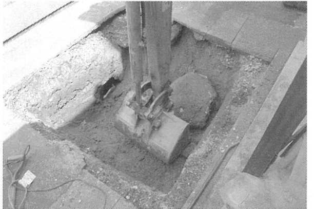
7区機械掘削(南から)
