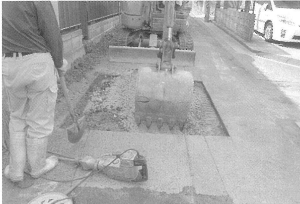
1区機械掘削(北から)
