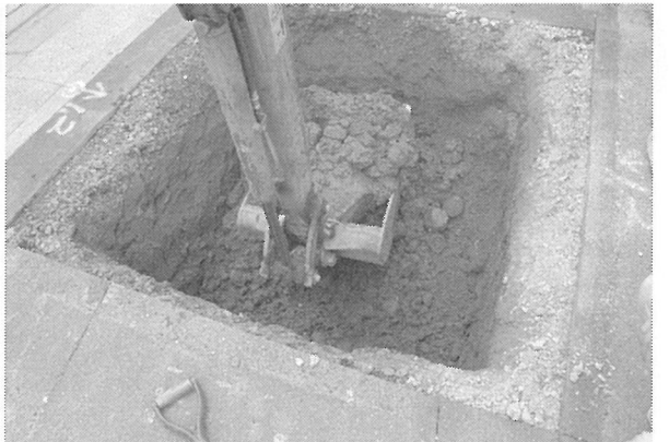
8区機械掘削(南から)
