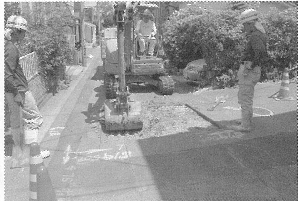
2区機械掘削(南から)
