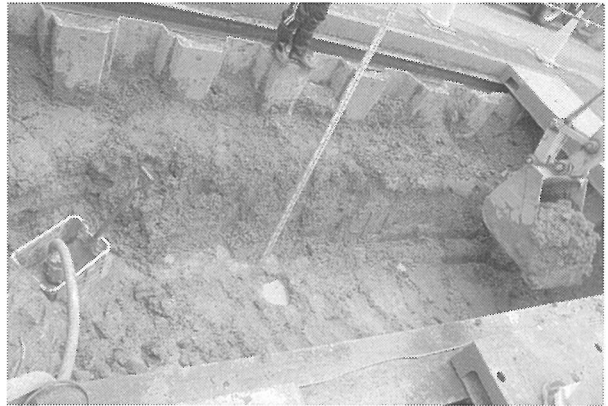
1区機械掘削(南西から)
