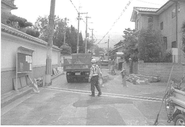
1区調査地(西から)
