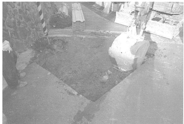
2区機械掘削(東から)
