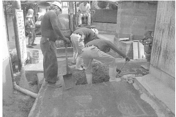
10区掘削状況(南から)
