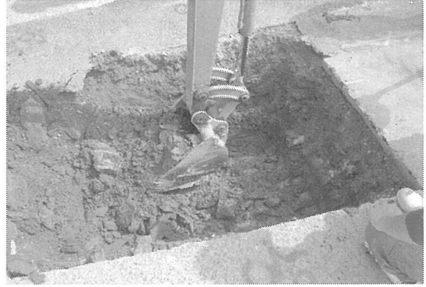
3区機械掘削(南から)
