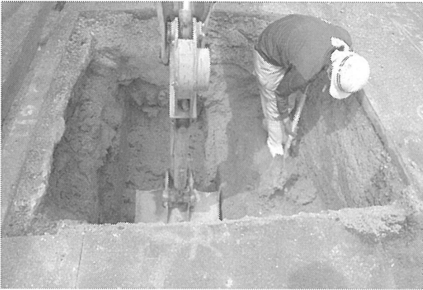
4区掘削状況(南から)
