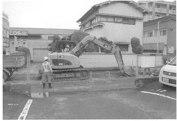
2区機械掘削(南から)
