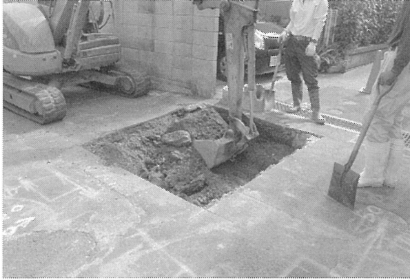
6区機械掘削(南西から)
