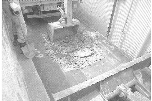
11区機械掘削(北東から)
