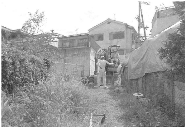
3区調査地(西から)
