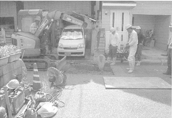
2区機械掘削(西から)
