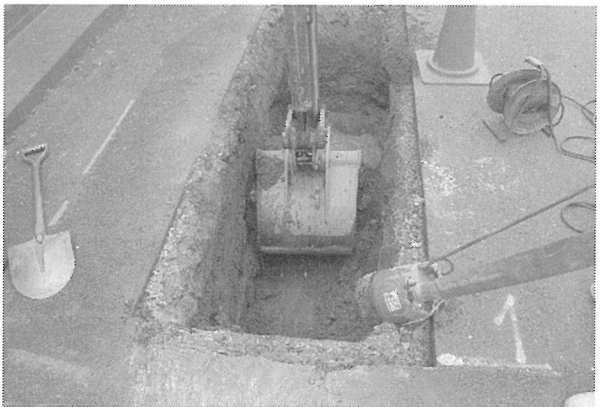
2区機械掘削(西から)
