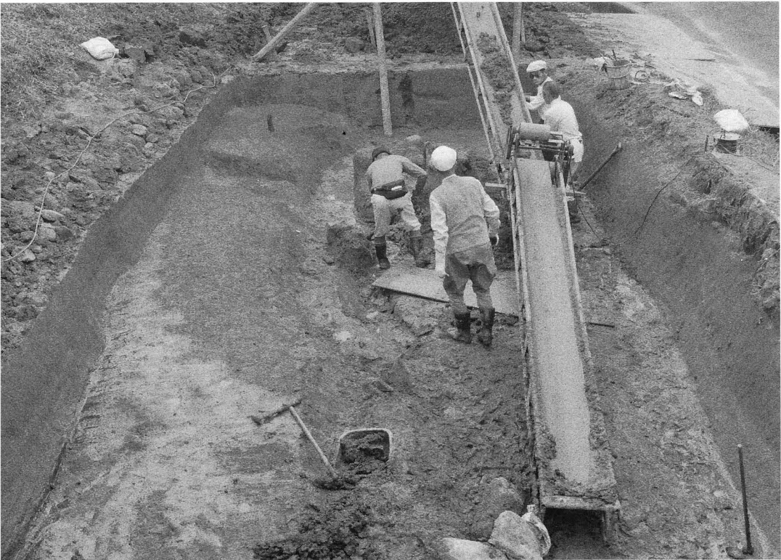
人力掘削状況（北西より）
