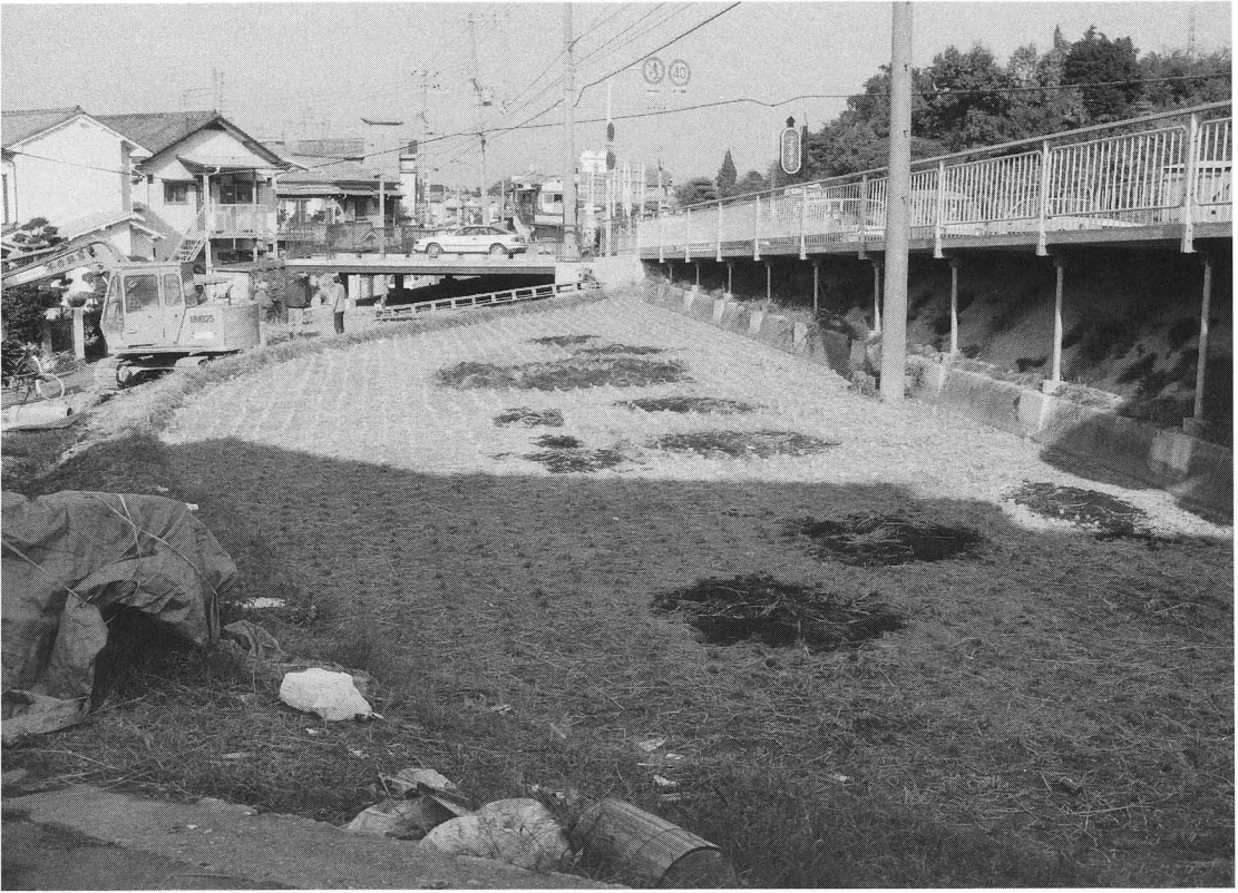
調査地遠景（南東より）
