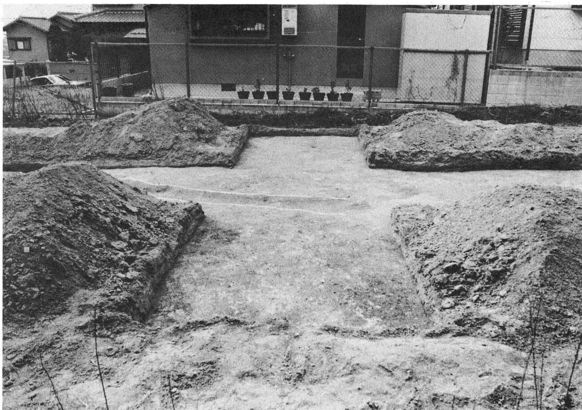
第2トレンチ(東より)
