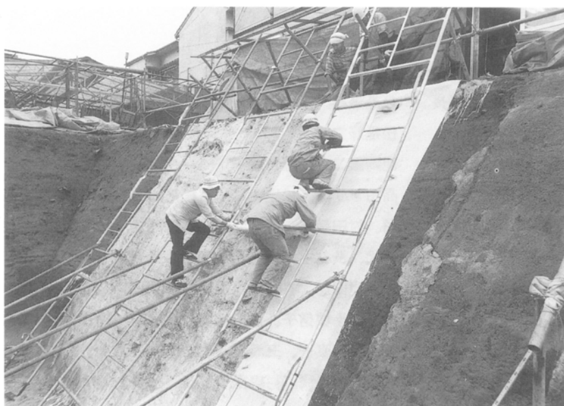
図1 S F - 049土層剥ぎ取り作業風景
