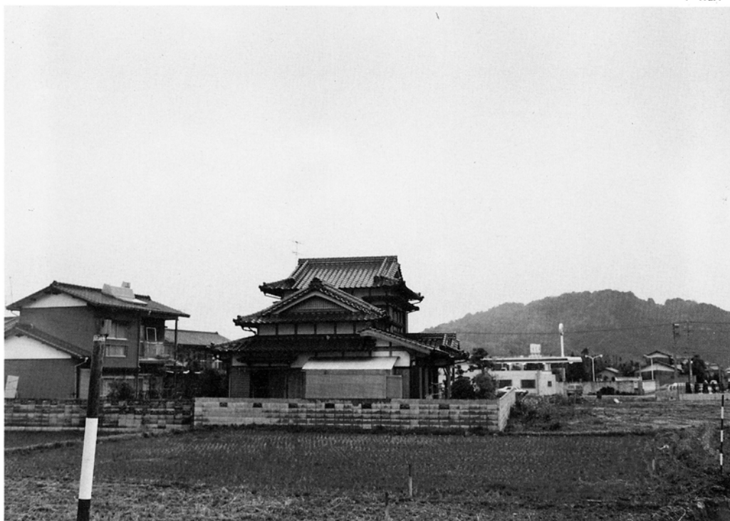
▲調査前（西から）
