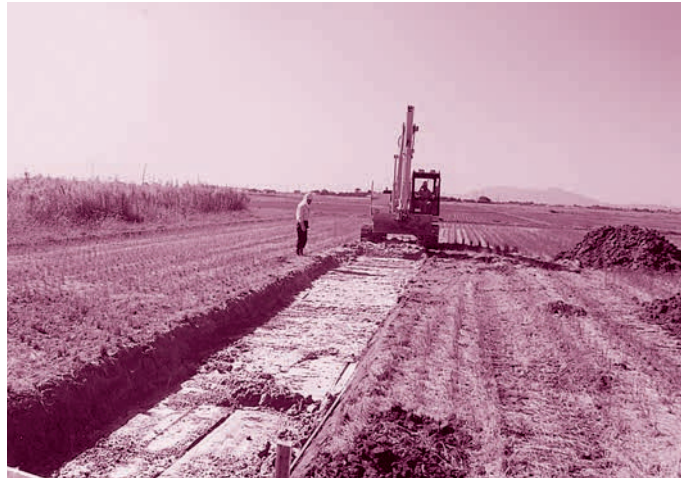
C区 表土掘削作業(東から)
