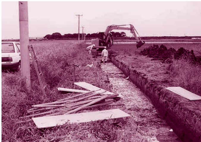
A区 表土掘削作業 (南から)
