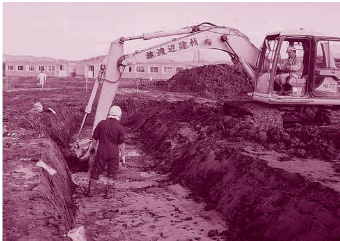
I区 表土掘削作業 (西から)
