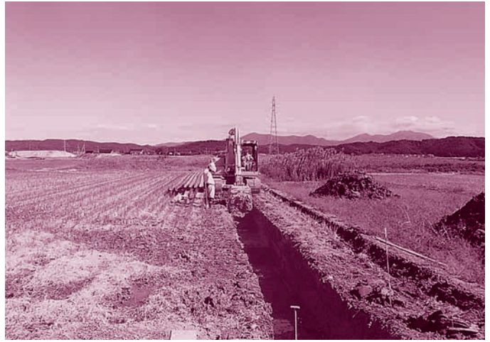
B区 表土掘削作業 (西から)
