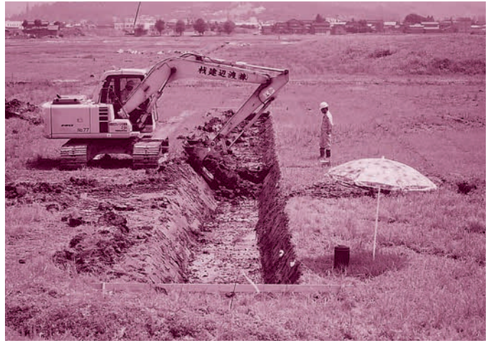
D区 表土掘削作業(西から)
