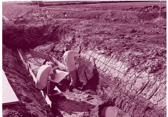
C区下層 遺構断面実測作業(南東から)
