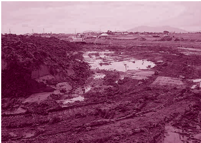
I区 近景 (南東から)
