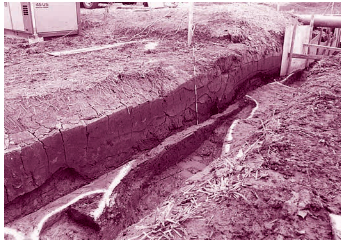
B区 SD12 断面 (南西から)
