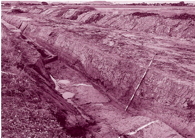
G区 河川9・河川10 断面 (南東から)
