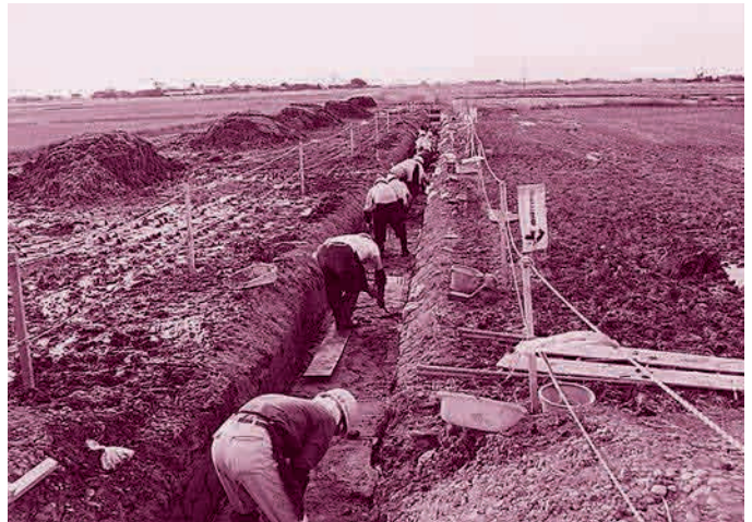
B区 遺構発掘作業 (東から)
