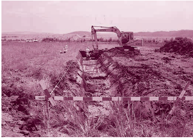
C区 表土掘削作業(西から)
