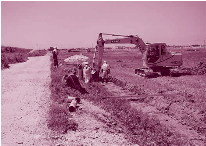
E区上層 表土掘削作業（北東から）
