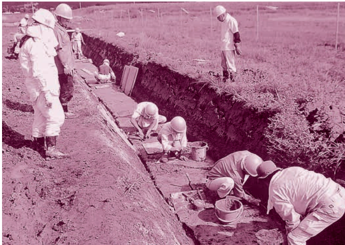
D区 遺構発掘作業(北東から)
