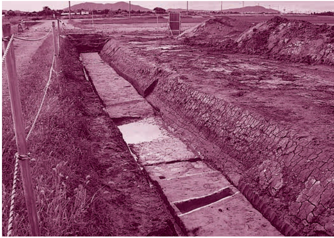
G区 河川5 全景 (南東から)
