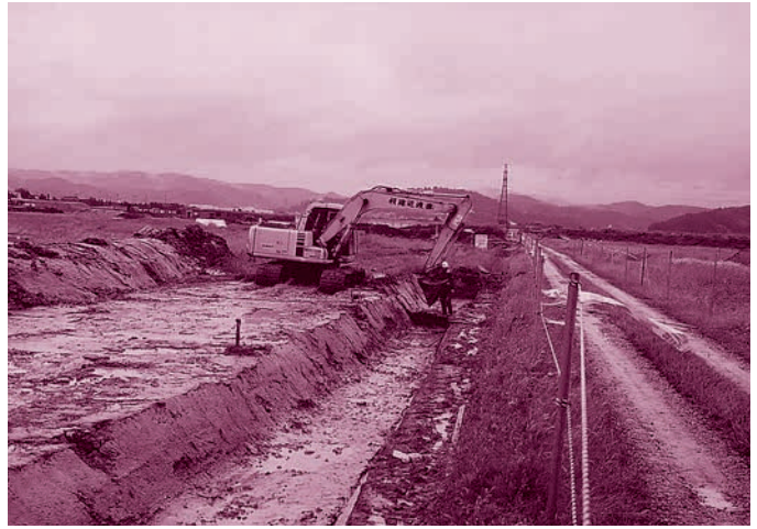
G区 表土掘削作業 (西から)
