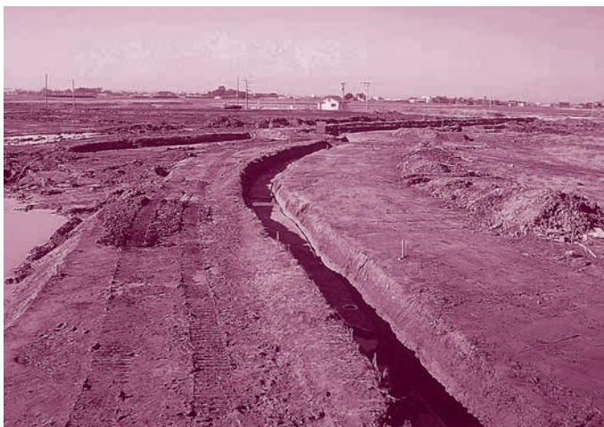
F区 全景 (東から)
