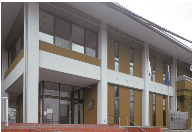
写真58 改修後外観 - 北西から -
