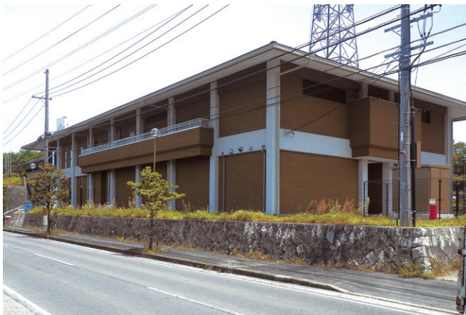
写真57 改修後外観 - 南西から -
