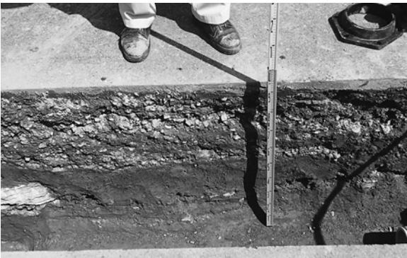
写真9 2 地点北壁 (南から)
