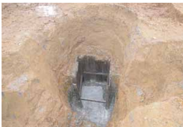
4 S E 1005井戸枠検出状況②(南→)
