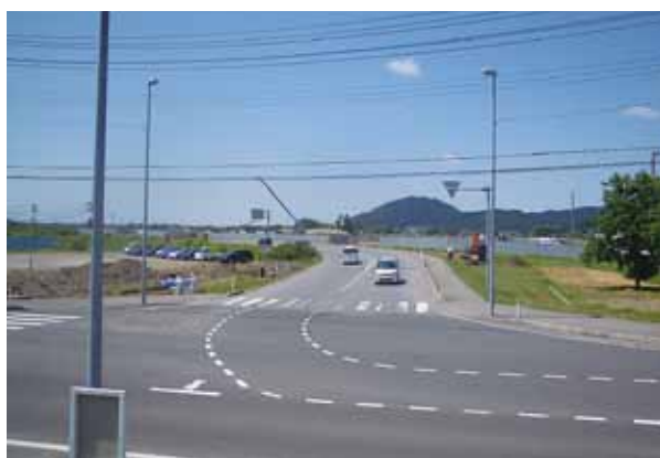
2 平成13・14年度調査区現況(南→)
