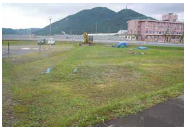
4 平成25年度B区調査前風景(南→)
