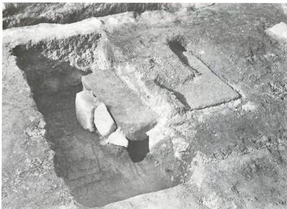
(1) 東小舟の補修部分
