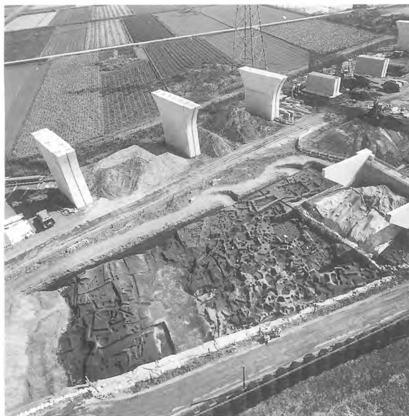
(1) 2区北側全景 (空中写真)
