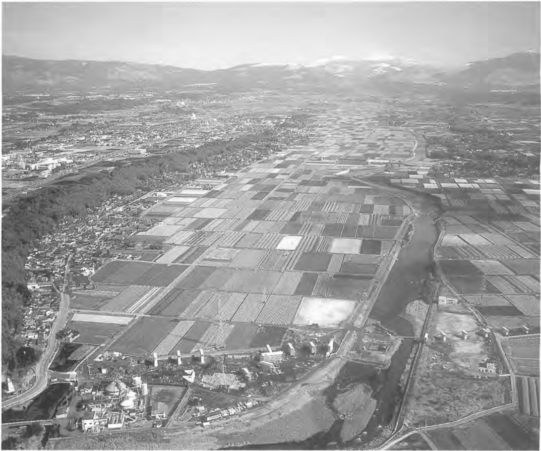
遺跡周辺航空写真（西から）
