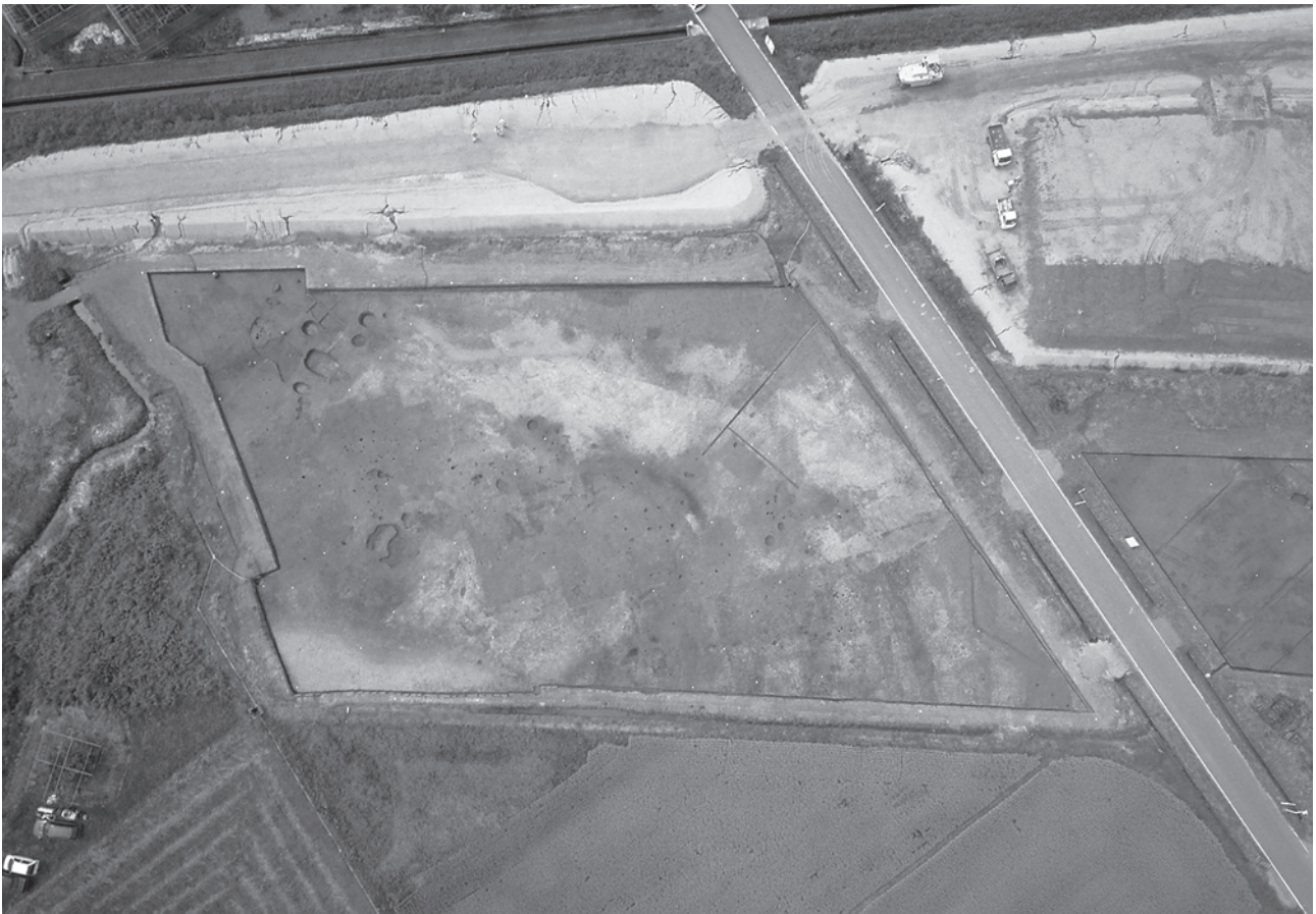
A区全景空中写真（上が南西）
