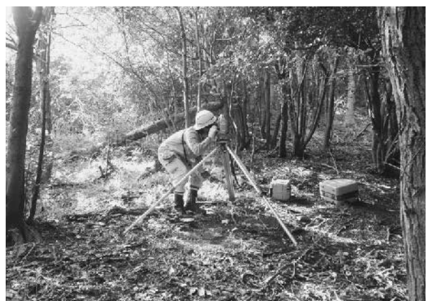
測量基準点の設置作業
