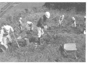
写真 5 表土除去作業状況
