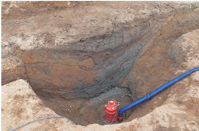
井戸 SE560 断面 (第1次調査区, 北西から)
