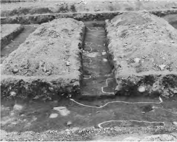
図版9 10区検出状況（南から）
