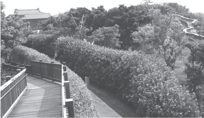
首里城西のアザナ付近から 復元整備された京の内一帯を 西側より望む
