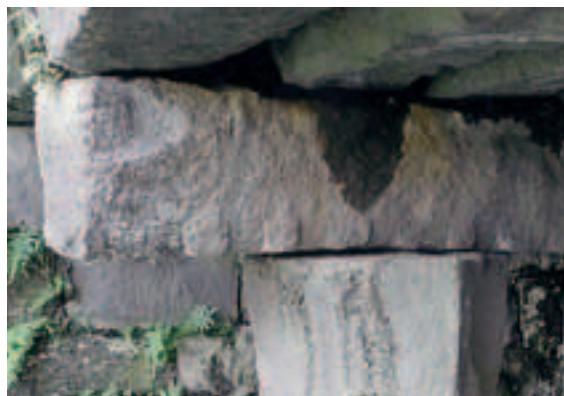
PL.165 桁橋の橋脚・梁材に残る矢穴
