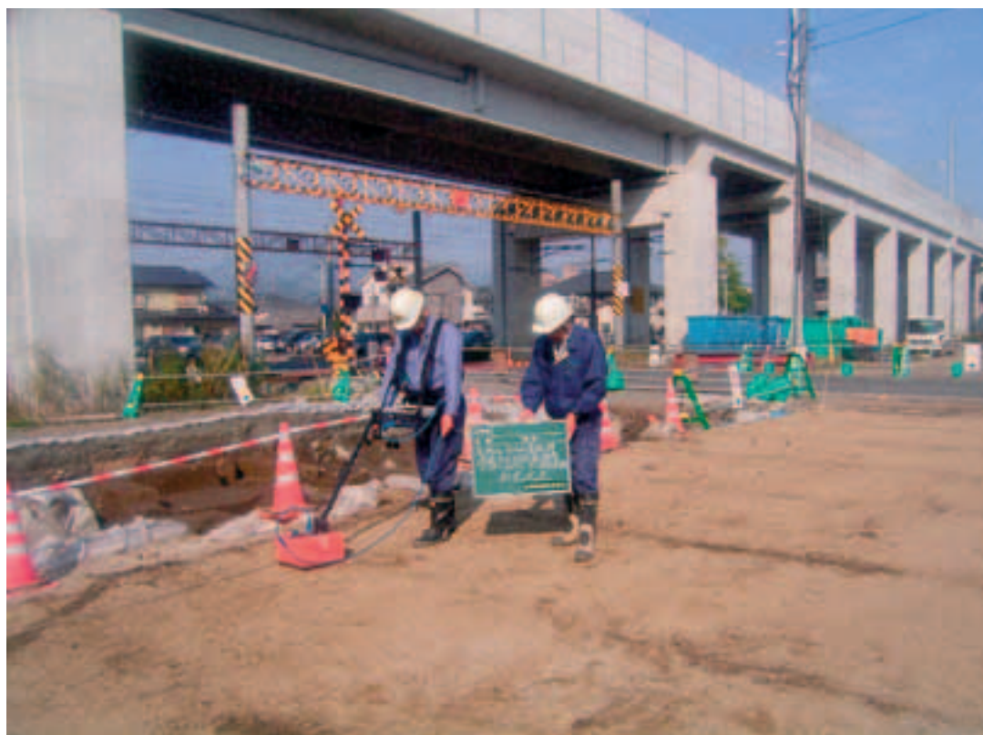
PL.101 地中レーダー探査測定状況
