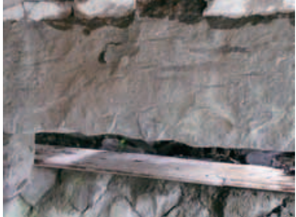
PL.170 同左・石橋の梁石材に残る矢穴
