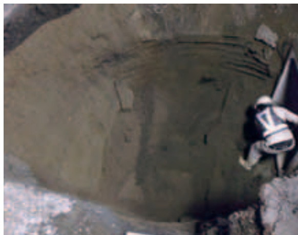
PL.77 夜間工事立会
