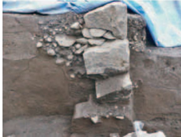
PL.157 No.1 トレンチの根切り状況
