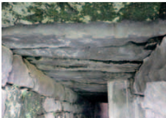
PL.164 桁橋下部の石組み（床石）
