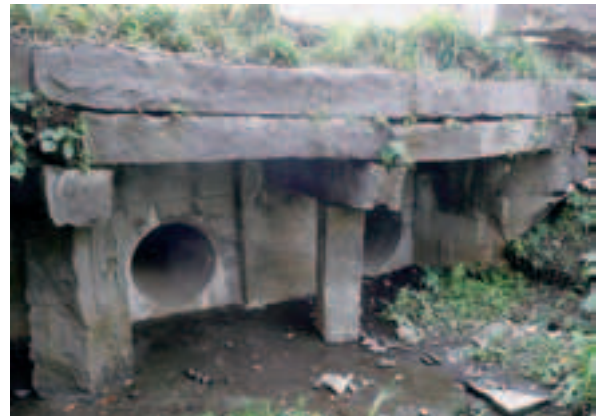
PL.163 桁橋の詳細と水制（水切り）
