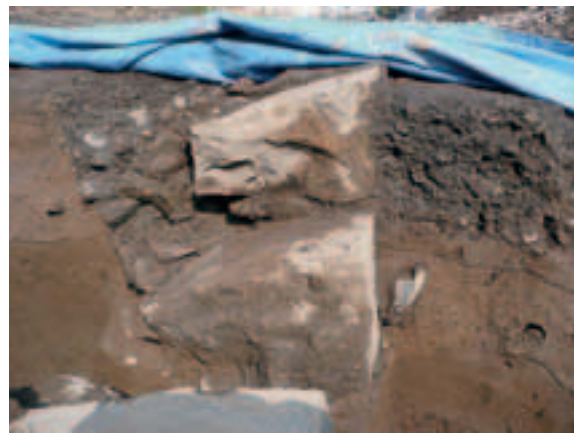
PL.159 同トレンチの根切り状況
