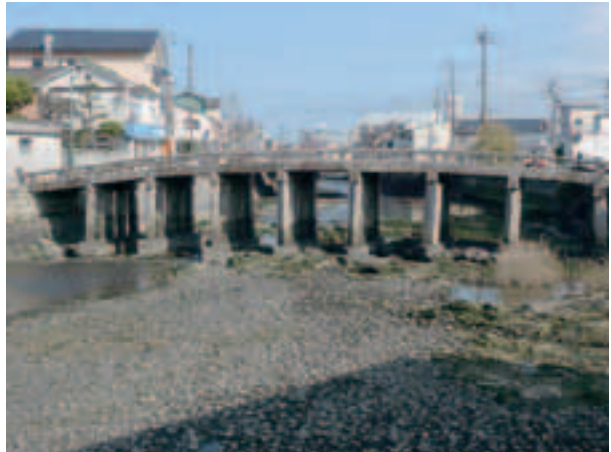
PL.172 同左・祇園橋の四角柱橋脚
