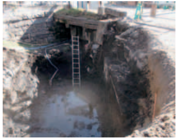
PL.86 橋台・水路・桁橋の配置状況
