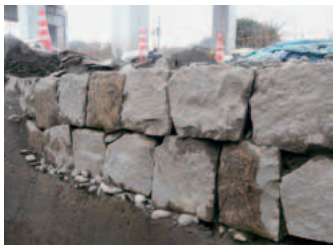
PL.155 同石垣の構築状況
