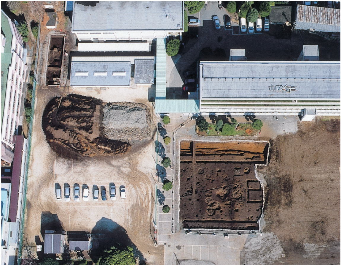
神水遺跡調査区全景（真上から）
